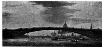
Telford: proyecto de un puente de hierro fundido para reemplazar al Puente de Londres. 1801.
