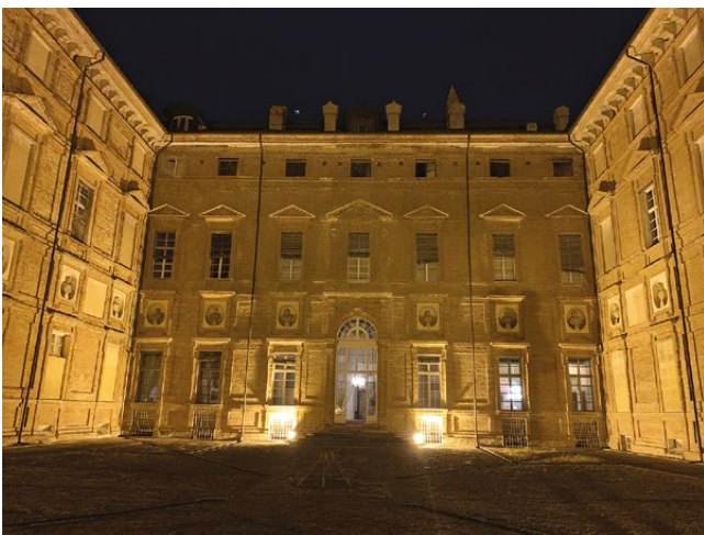
fig. 3 – Castello di Aglié. La corte interna di San Massimo, vista da sud verso nord.
