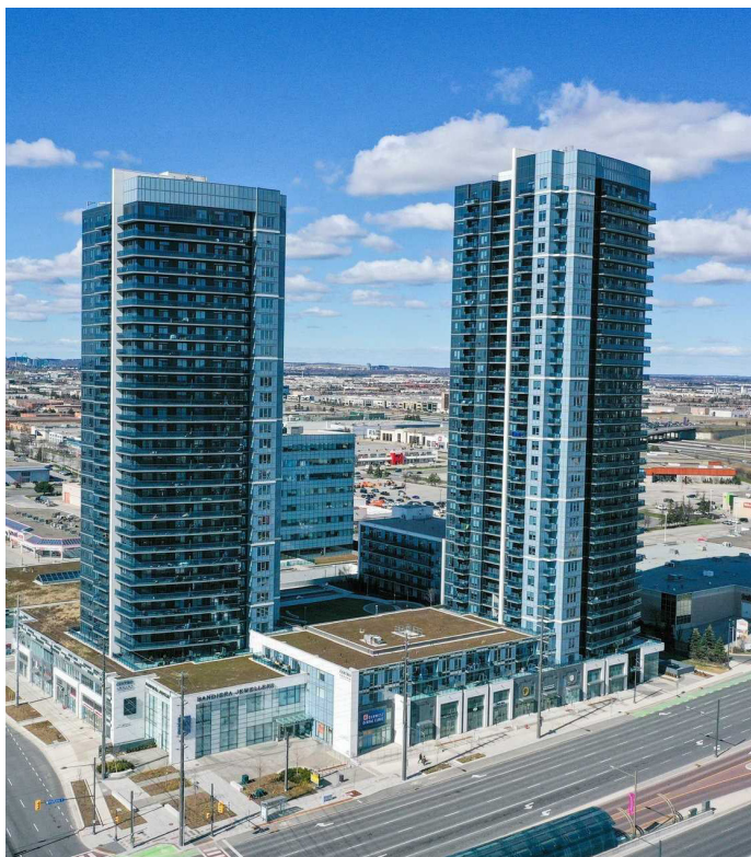
Fig. 3.35.1 Prime costruzioni del Vaughan Metropolitan Centre
