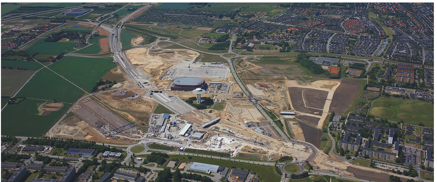
Figura 3.23.1 Visione aerea cantiere Hillie Smart District ©By Rjaber
