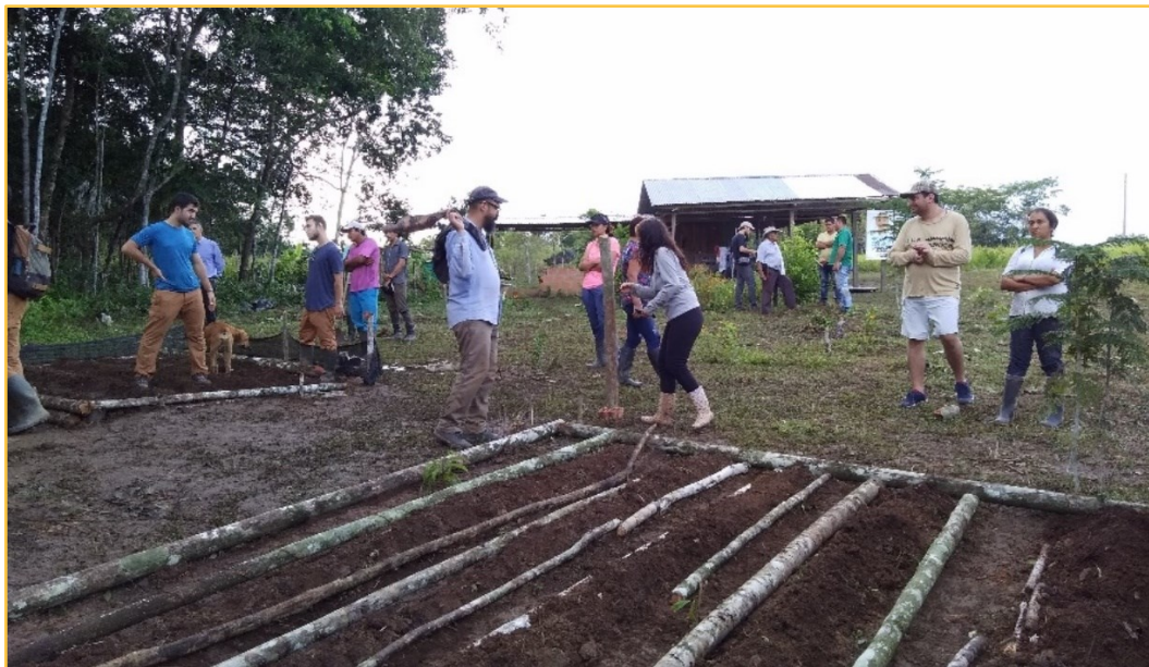
Fig. 35: Community Garden construction in Charrasquera. By Diaz Diaz, 2019. Construcción del huerto comunitario en Charrasquera. Por Diaz Diaz, 2019.
