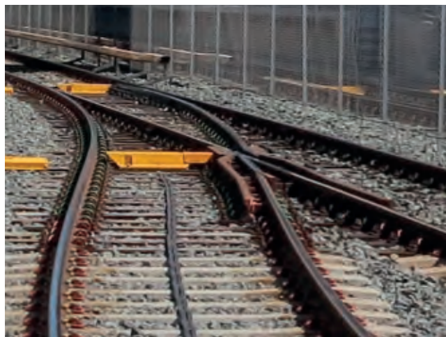
Figura 11 – Deviatoio con cuore mobile in stazione di Bekkestua.
