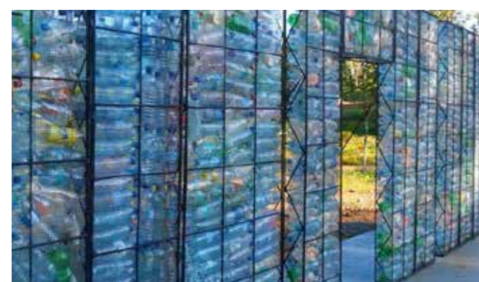
Muro realizzato con bottiglie di plastica da: https://rivistanatura.com
