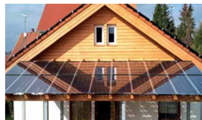
Pensilina fotovoltaica da: https://www.fotovoltaiconorditalia.it
