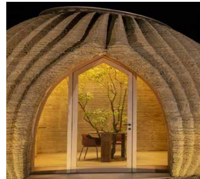
"Tecla" casa realizzata con l'utilizzo di una stampante 3D, Mario Cucinella Architects da: https://www.3dwasp.com
