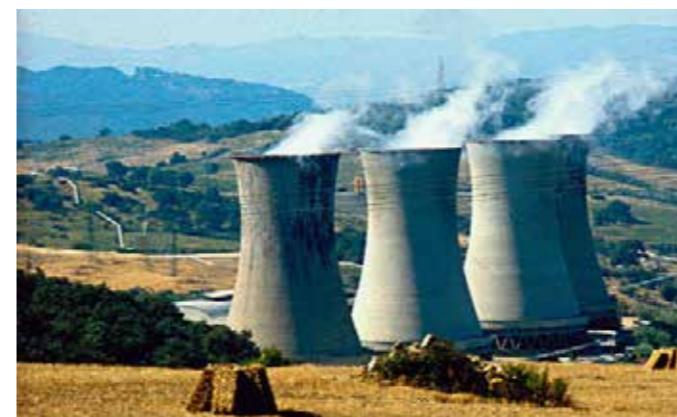
Centrale geotermica da http://www.risparmio-energetico.com
