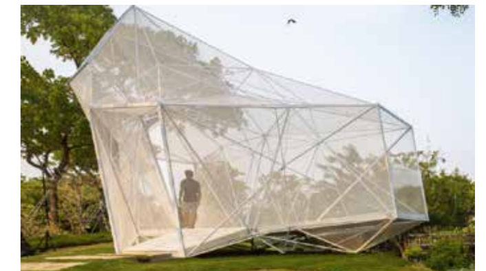
Edificio temporaneo realizzato con acciaio stampato in 3D, Architectural Intelligence Research Lab, 2020 da https://www.springwise.com
