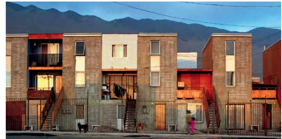
Alejandro Aravena, progetto di quartiere residenziale a Quinta Monroy, Iquique (Chile), 2001-2004 da https://arquitecturaviva.com
