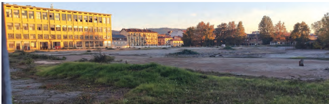
Ex-OGM Officine Grandi Motori –Lotto a nord di via Cuneo Lingottino e area ex industriale in parte abbattuta
