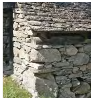
Figura 3 Edificio rustico all'Alpe Soi (Valle Anzasca). Muratura a secco formata con grandi cantonali non riquadrati, elementi minori grossolanamente lavorati e trovanti.
