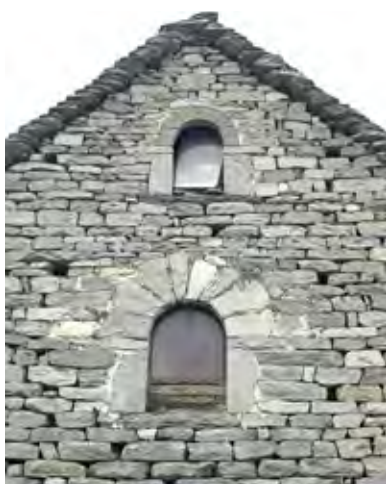
Figura 1 Edificio rustico a Pontetto di Montecrestese.
