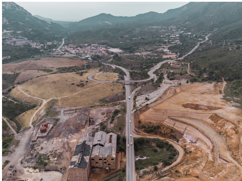
Figura 1. Vista sul sistema di valle delle miniere di Campo Pisano, Moteponi e San Giovanni. In primo piano la discarica “Fanghi Rossi” contenenti i residui di lavorazione dell’adiacente impianto. Fonte: Davide Simoni, 2020.
