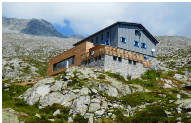
Figura 3. Ristrutturazione e ampliamento del rifugio Città di Trento al Mandrone, Livio Noldin, 2022.
