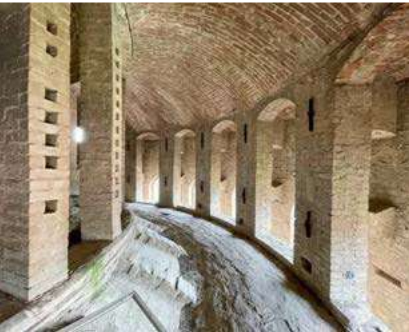
Fig. 20a, 20b. Vista sul piano extradossale della calotta absidale e sistemi di scale in muratura (2021).
