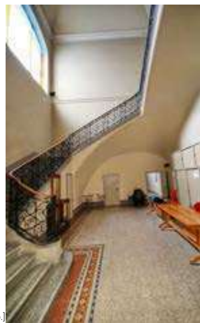
Fig. 4. Due recenti immagini dello scalone principale, realizzato durante gli Anni Venti con struttura in cemento armato demolendo una partizione orizzontale in volta a fasce [fotografie degli autori].
