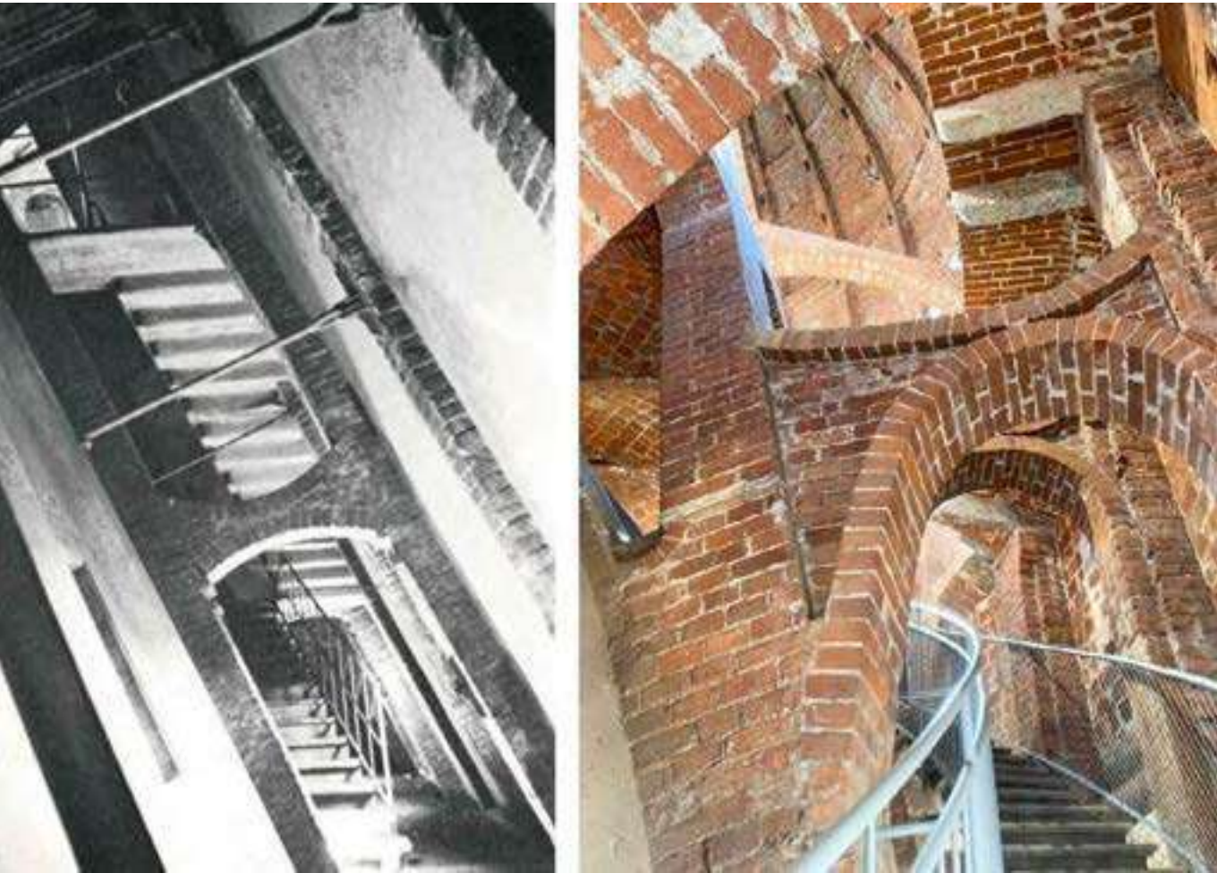
Fig. 5. Archi dritto-rovesci, nell'intercapedine del volto della Mole, a sinistra [Rosso, 1977], e nella cupola di San Gaudenzio, a destra [fotografia dell'autore].
