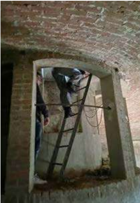
Fig. 26a, 26b. Scale metalliche, collegamenti di accesso al secondo terrazzino anulare (2021).
