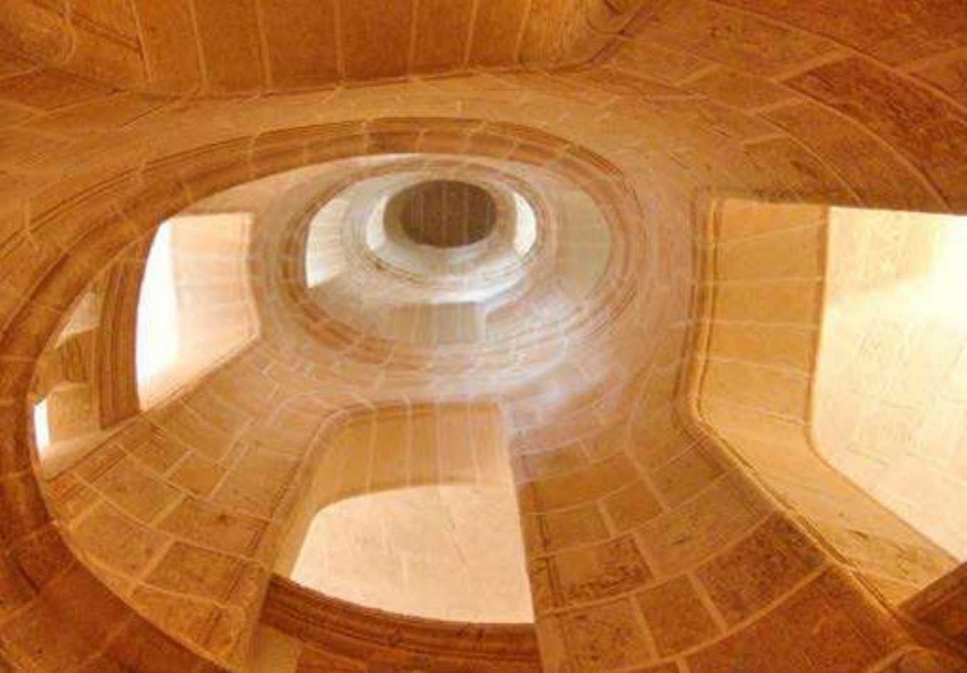
Fig. 5. Palazzo Verdala , Rabat (Malta), scala con pozzo centrale e con volta a botte elicoidale, seconda metà XVI secolo [fotografia dell'autore].
