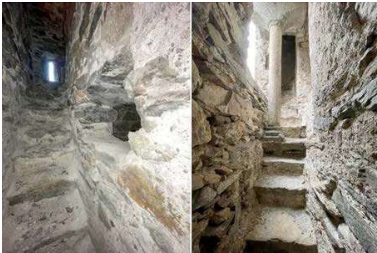
Fig. 8. Césara (Verbano Cusio Ossola). Interno della torre campanaria della chiesa di San Clemente, dettaglio della scala intra muros : risvolto angolare e livello delle bifore [fotografie dell'autrice, febbraio 2019].
