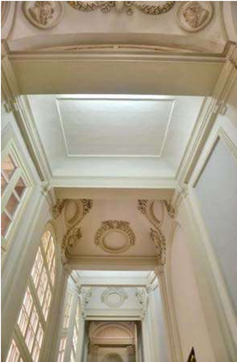
Fig. 10. Veduta della rampa principale della scala della Biblioteca della Valletta [fotografia dell'autore, 2017].
