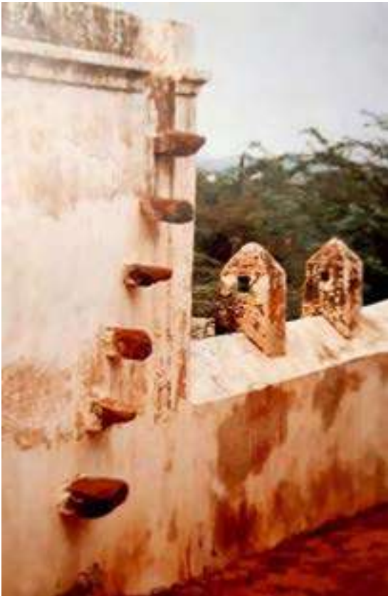
Fig. 4. Scala a sbalzo al palazzo Khetri Mahal, Rajasthan, circa 1770 [fotografia di Oriol Rosselló Viñas, in mostra a Rèquiem per l'escala ].
