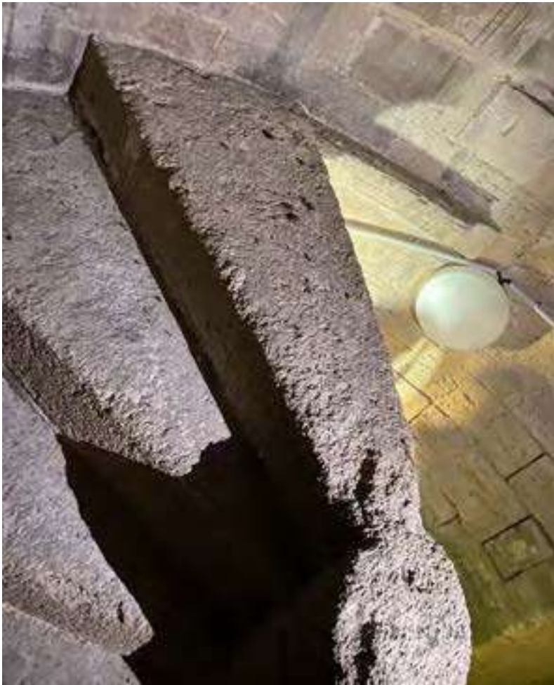
Fig. 7. Cattedrale di Coutances , terminazione della scala della torre nord della facciata [fotografia dell'autore]. Si noti l'attaccatura della modanatura con il muro d'ambito che non ammette ammorsatura per i gradini.
