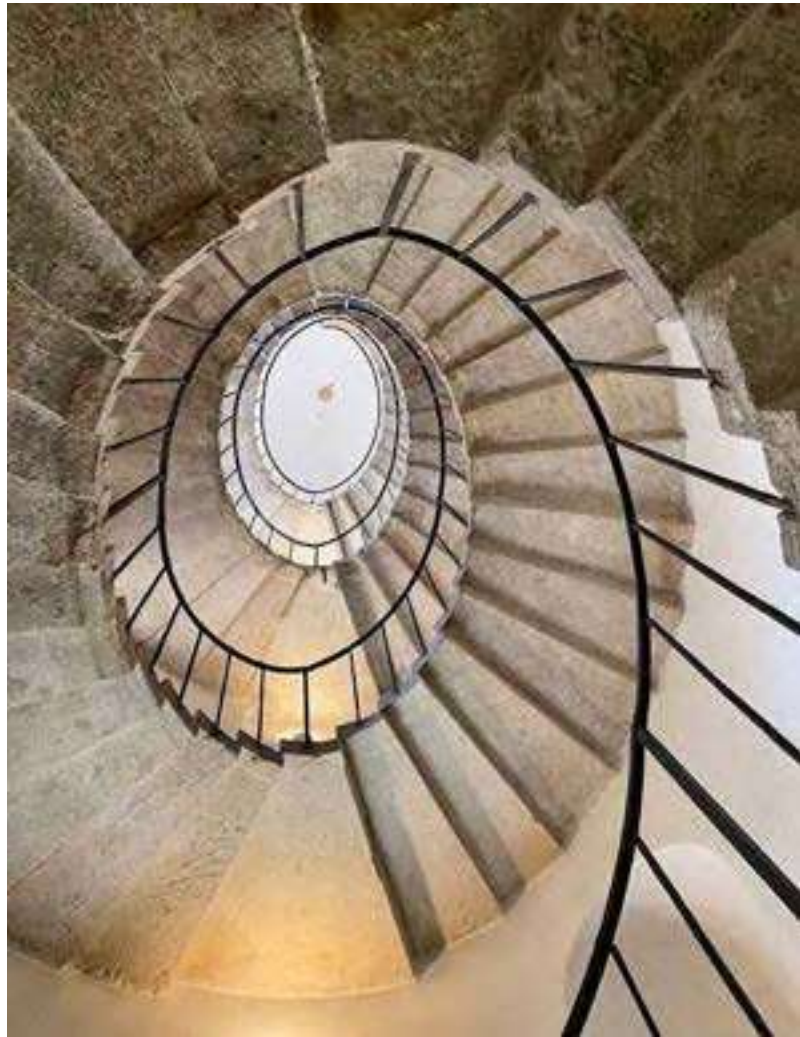
Fig. 7. Convento della Carità (Gallerie dell'Accademia) , Venezia, scala a palladiana a sbalzo [fotografia dell'autore].
