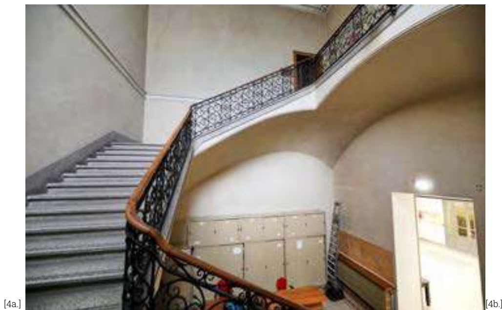
Fig. 4. Due recenti immagini dello scalone principale, realizzato durante gli Anni Venti con struttura in cemento armato demolendo una partizione orizzontale in volta a fasce [fotografie degli autori].
