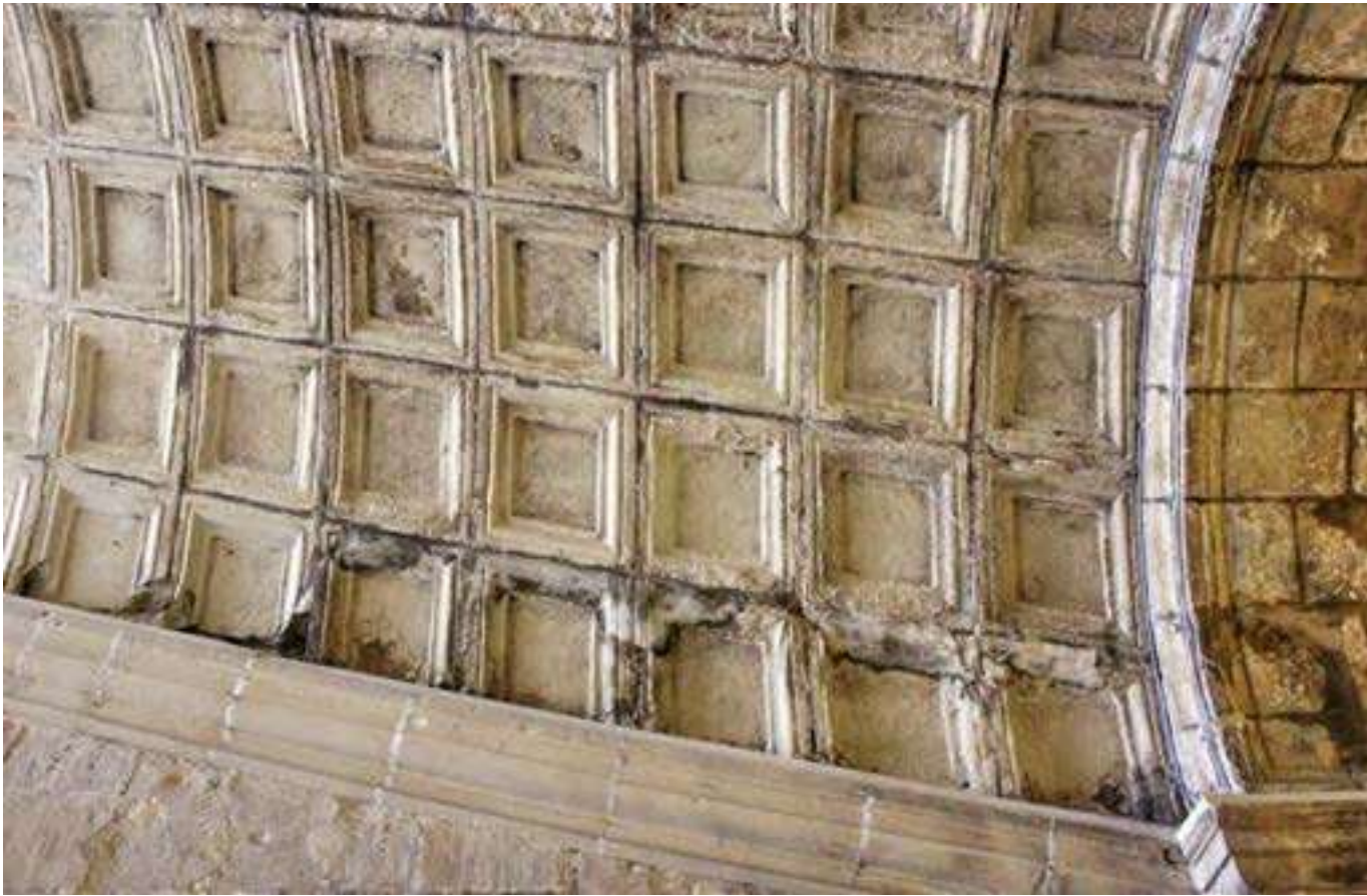
Fig. 2. Volta a botte inclinata sopra la scala della Sacra Infermeria, La Valletta [fotografia dell'autore, 2017].
