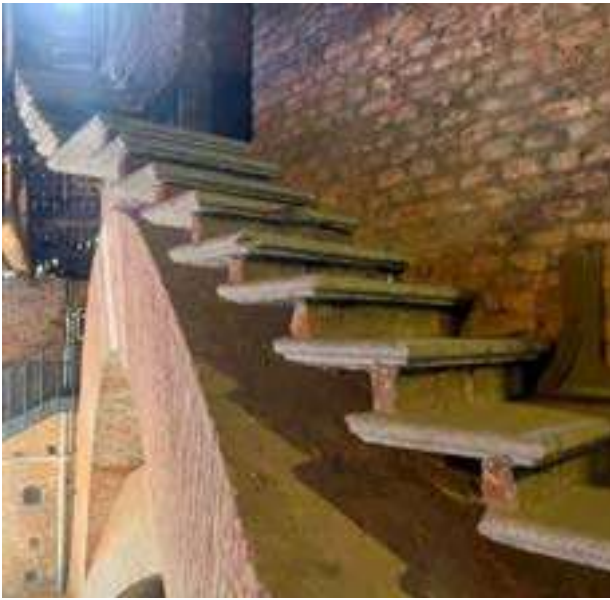
Fig. 3. Scale a sbalzo alla base del tamburo di San Gaudenzio, a sinistra [fotografia dell'autore], e nel Santuario di Boca, a destra [Fondo Franco Rosso, Archivio di Stato di Torino].
