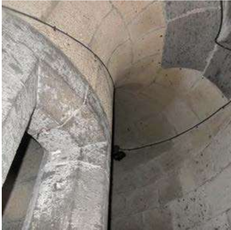
Fig. 3. Castelnuovo , Napoli, scala con volta a botte elicoidale, metà secolo XV [fotografia dell'autore].
