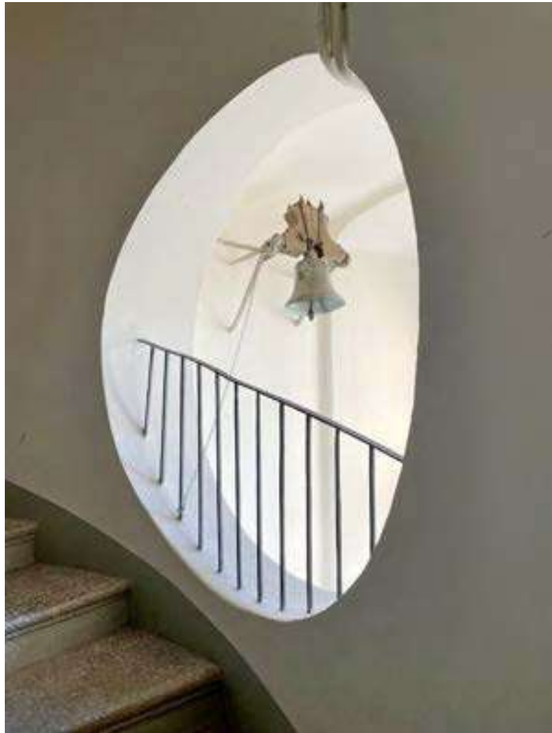
Fig. 12. Grande occhio circolare nella scala juvarriana di Superga, aperto verso l'intercapedine luminosa. L'arco rovescio ha funzione di sostegno degli scalini a sbalzo [fotografia dell'autore].
