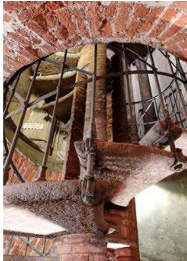
Fig. 4. Scale a sbalzo elicoidali nella Mole: il sistema bilaterale di connessione tra le lastre lapidee – a sinistra nel rilievo di Franco Rosso [Rosso, 1977], a destra in una vista di dettaglio [fotografia dell'autore].
