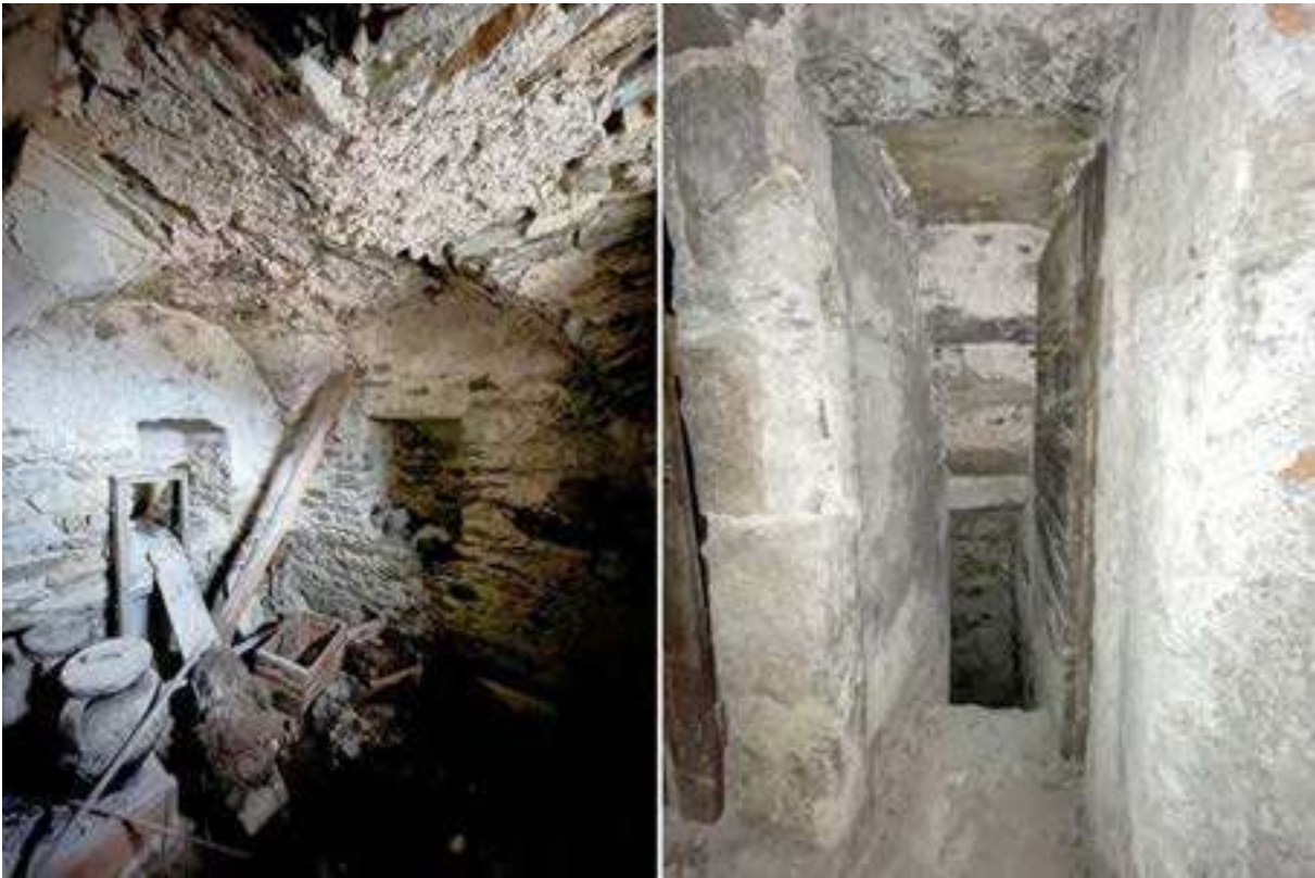
Fig. 7. Césara (Verbano Cusio Ossola). Interno della torre campanaria della chiesa di San Clemente, ambiente seminterrato coperto a crociera nervata e rampa di accesso [fotografie dell'autrice, febbraio 2019].
