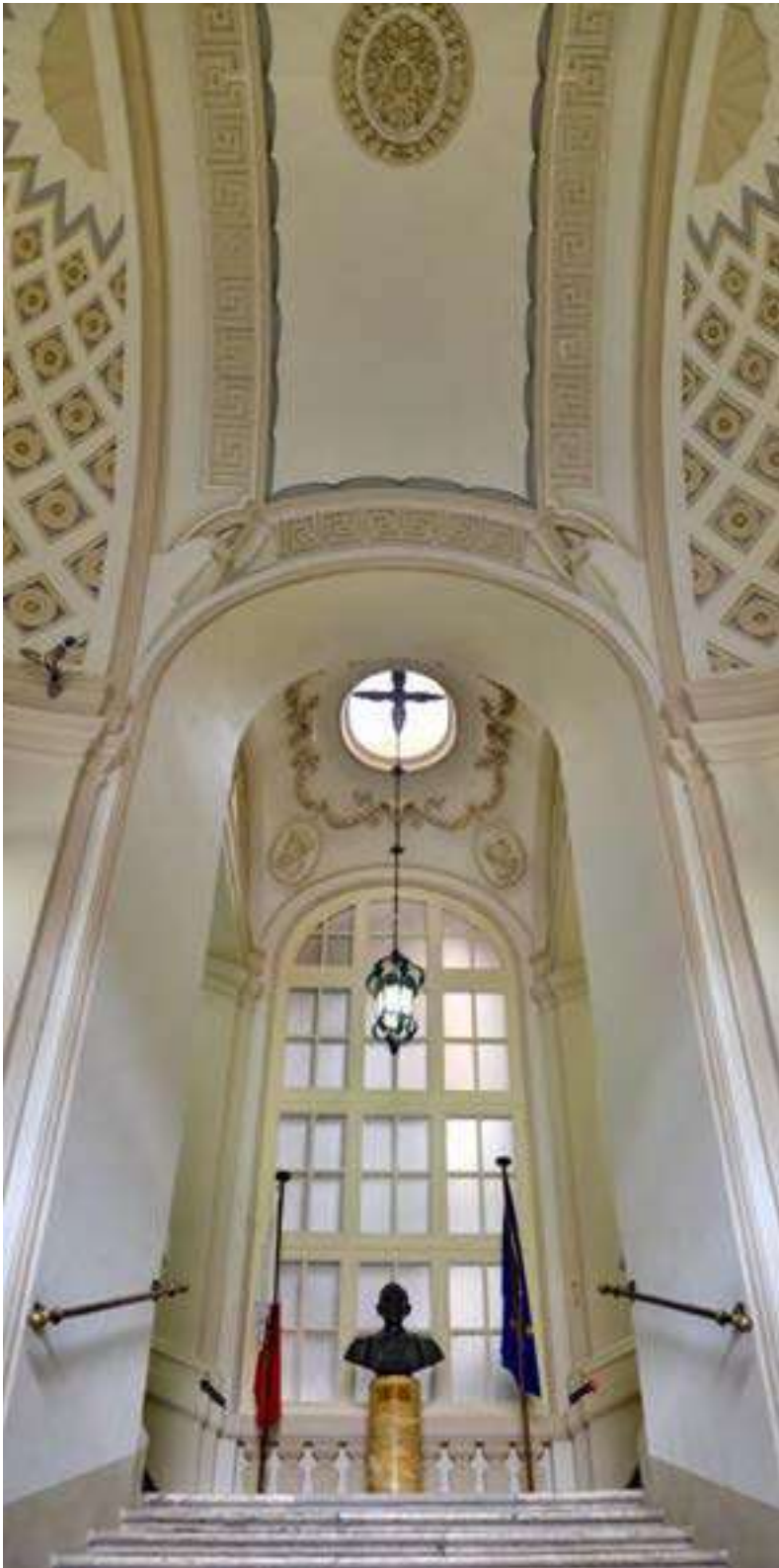
Fig. 9. Veduta della prima rampa della scala della Biblioteca della Valletta, sormontata da una volta a botte inclinata [fotografia dell'autore, 2017].
