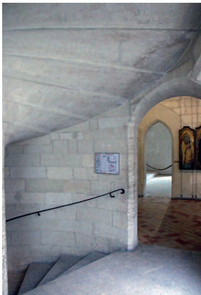
Fig. 5. Avignone. Petit Palais, interno della torre scala.
