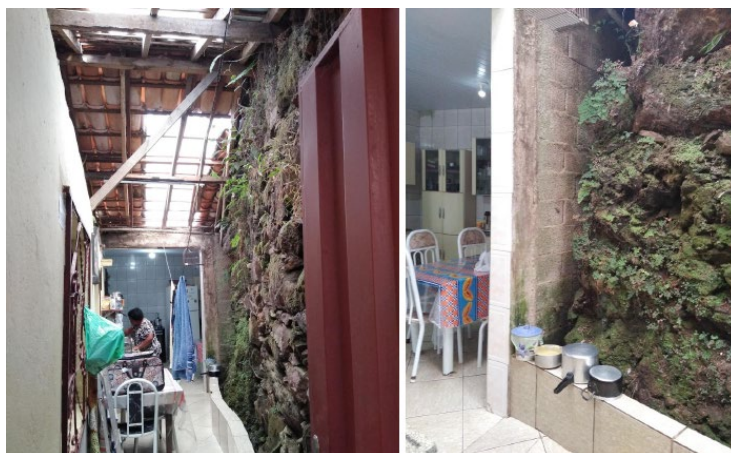
Imagem 3 e 4: Cozinha da residência, ambiente em que parte do mundéu está exposto, sendo uma das paredes estruturais.
