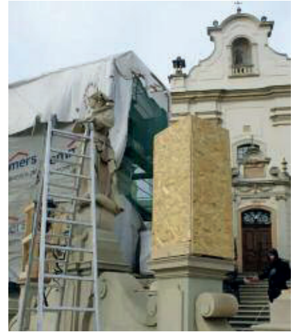
Fig. 7 Protezione di una statua di una piazza in Ucraina in previsione di possibili bombardamenti, febbraio 2022.
