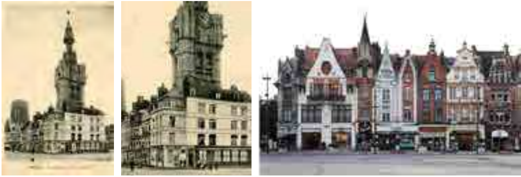
4: Confronto tra la Grand'Place nel 1887 (con gli edifici poi rimossi) e dopo la ricostruzione in stile flamingant .
