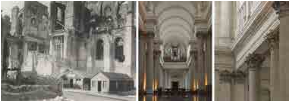
2: A sinistra: la navata della cattedrale dopo i bombardamenti; al centro e a destra, la stessa navata dopo i lavori di ricostruzione.
