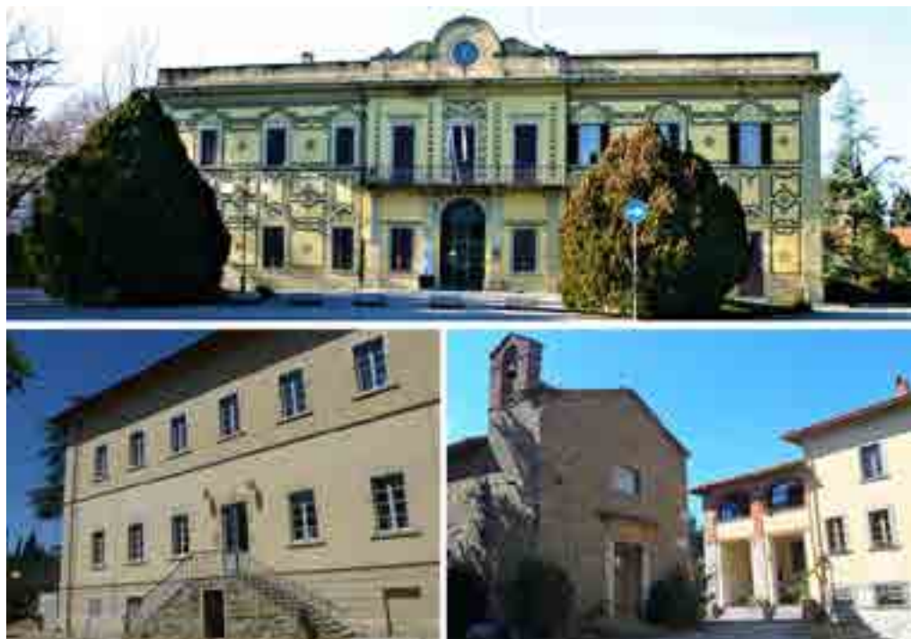
2: Ex Manicomio provinciale, poi Ospedale neuropsichiatrico di Arezzo. La Palazzina della direzione, detta dell'Orologio e il padiglione infermeria donne (poi colonia industriale femminile), oggi uffici dell'Università di Siena, campus di Arezzo. In basso a destra la chiesetta nella colonia agricola maschile [Fotografie dell'autrice].
