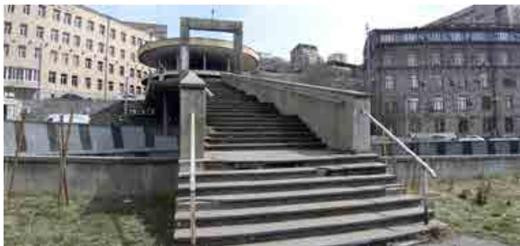
5: Yerevan, la stazione della funicolare in Koryun Street, completamente abbandonata [foto S. Pistidda 2022].
