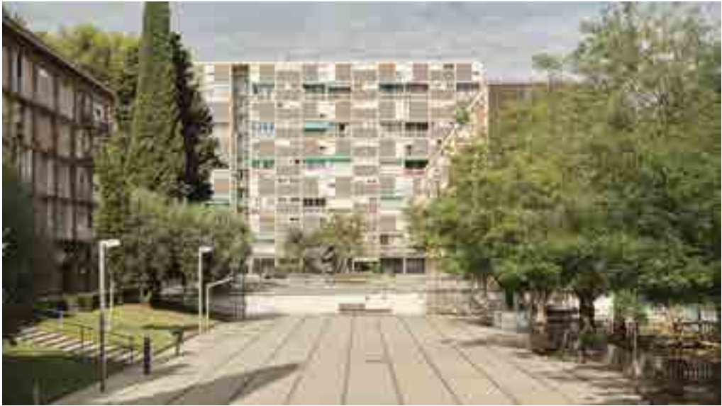
5: Aran Tiepolo, fotografia del quartiere di Montbau oggi, 2022.
