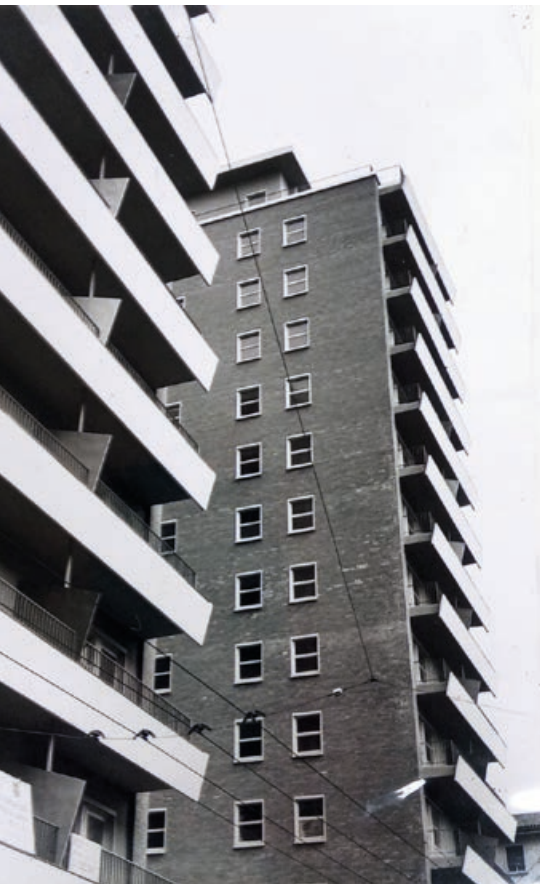
Fig.2 - I due edifici in un'immagine di fine cantiere, prima metà degli anni cinquanta (UNITS, ASCR, fondo Costa)
