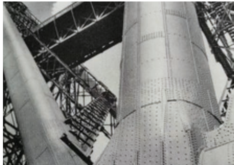
Fig.8 - Il Forth Bridge, le strutture in acciaio. Da Baxandall M. (2000)... cit.
