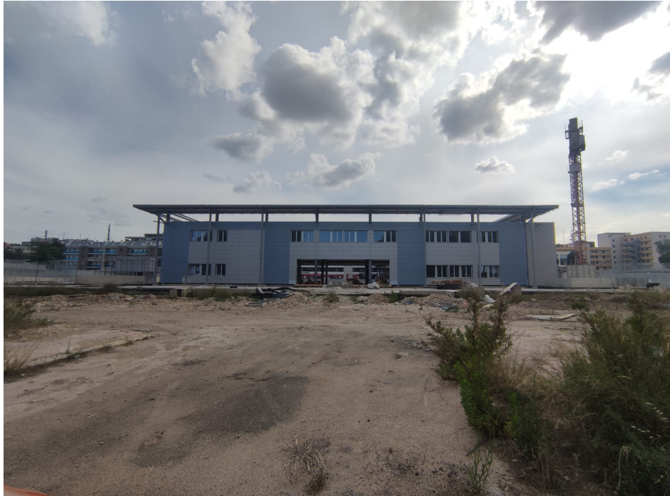
Figura 11 | Cantiere nuovi uffici.
