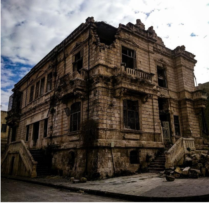
الشكل 2. مبنى الهجرة والجوازات (البلدية القديم) بعد القصف.
