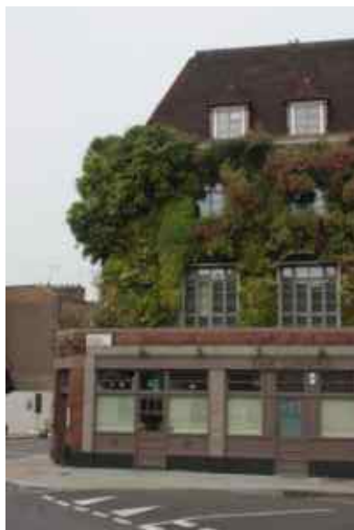
Esempio di inverdimento delle facciate, The Driver (foto di Katia Perini)
