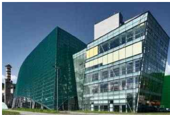
Impianto di Termovalorizzazione, Bolzano
