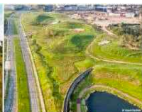
Krupp Park: il canale di drenaggio delle acque meteoriche.
