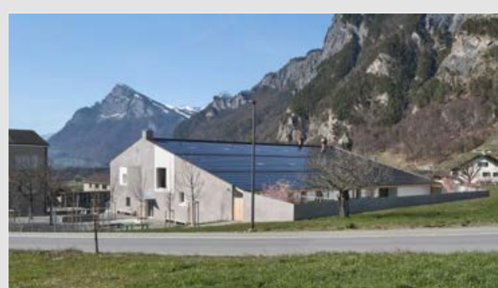
Ristrutturazione e ampliamento edificio multiuso di Fläsch
