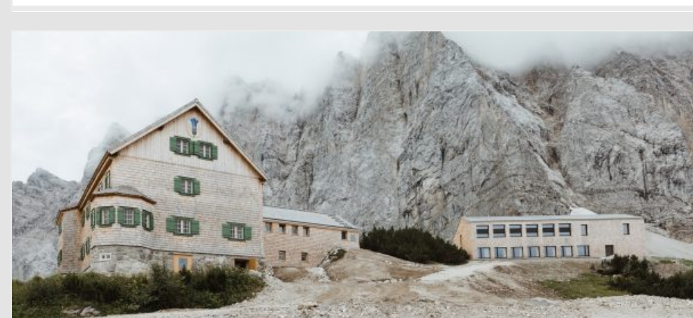
Ristrutturazione generale Falkenhütte (rifugio)
