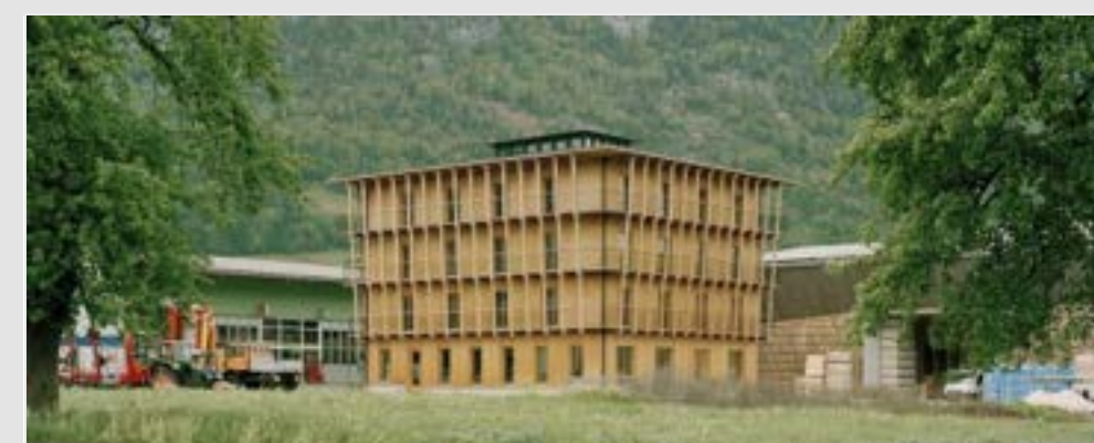
Edificio per uffici Küng
