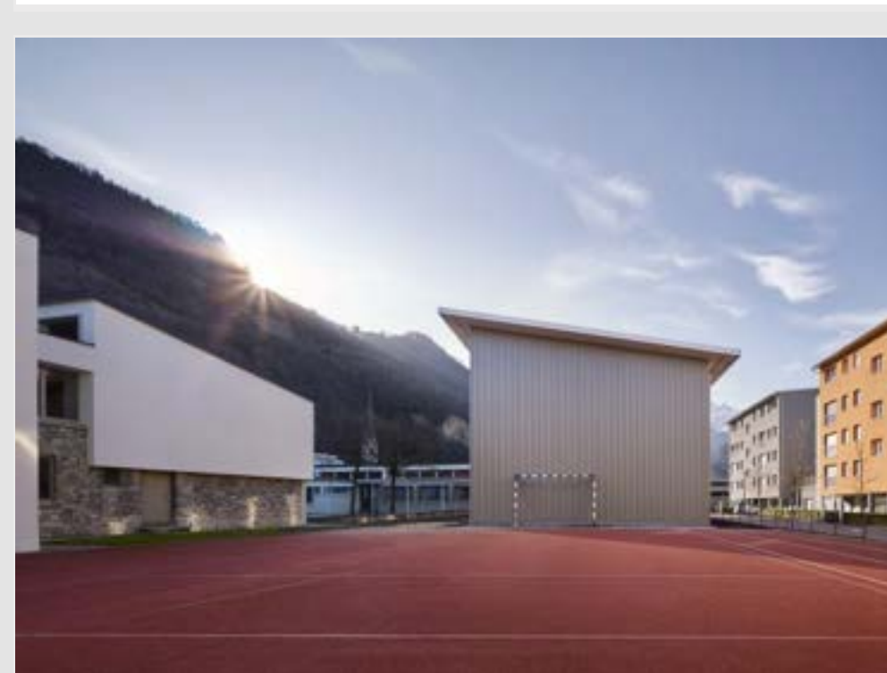
MATADOR - Edificio scolastico temporaneo
