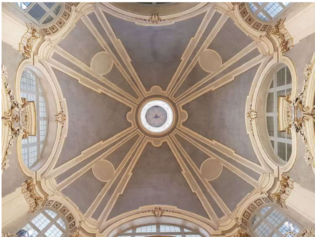
5: Chiesa di Santa Chiara, la volta dell'aula liturgica dopo il restauro.
