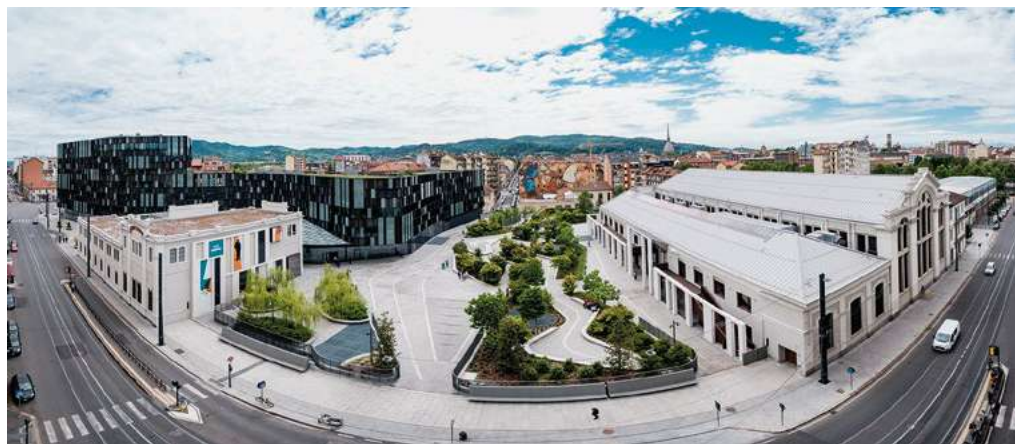
1: Panoramica dell'esterno della Centrale Nuvola Lavazza.
