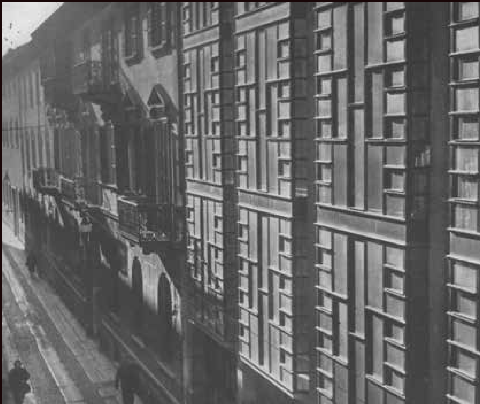
Particolare della fronte vetrata su strada (da Francesco Tentori, Nel clima italiano: lo Studio Architetti Associati di Novara , in «Casabella-Continuità», n. 259, gennaio 1962, p. 41)
