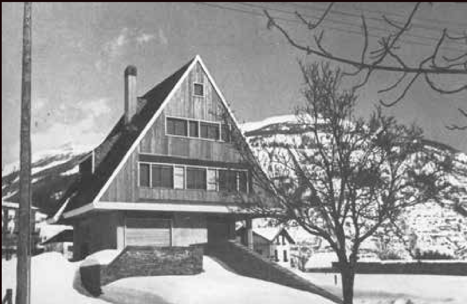
Vista esterna (da Red., Villa Cirio a Bardonecchia . Architetto Augusto Romano, in «L'architettura. Cronache e storia», n. 8, giugno 1956, p. 103)
