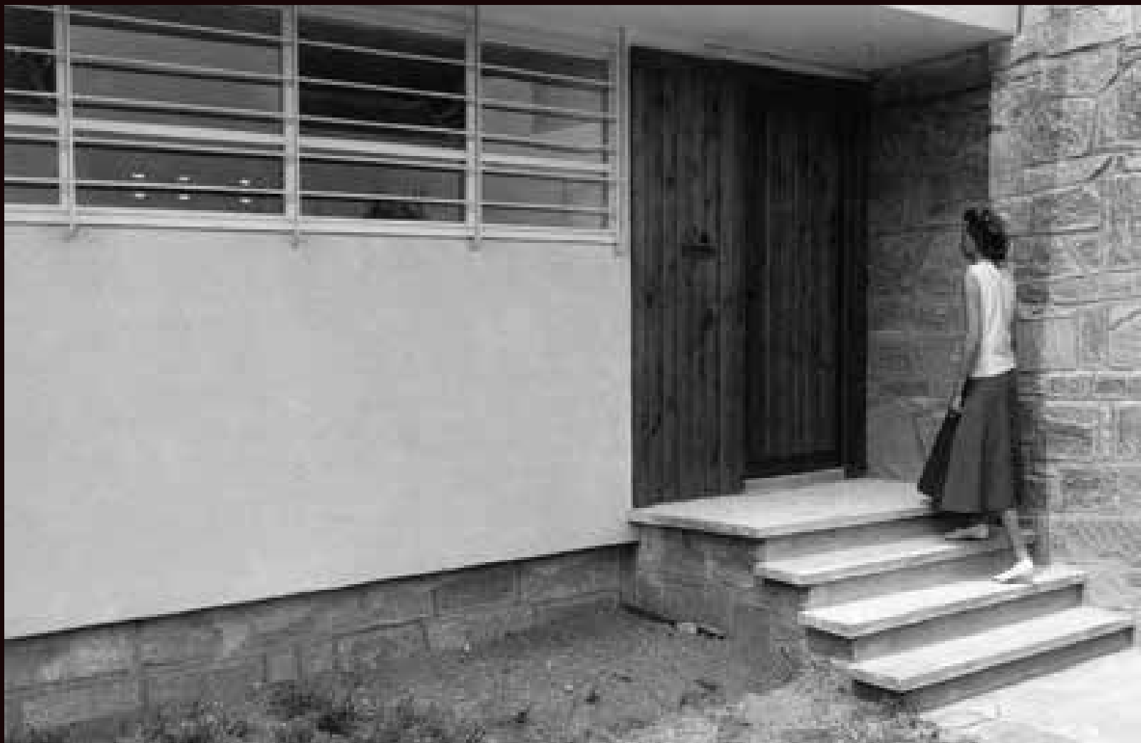
Ingresso di un'abitazione, 1953 (da D. Regis, L. Battaglia, Augusto Romano Architetto , Celid, Torino 2012, p. 14 foto Augusto Romano)
