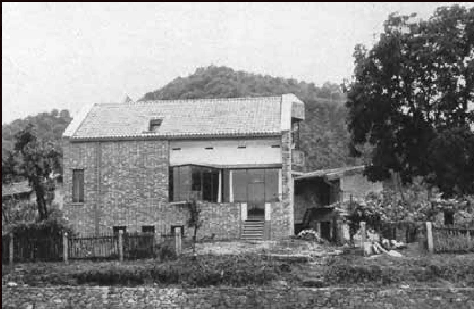
Fronte ovest della casa con la veranda di soggiorno (da «Casabella-Continuità», n. 112, settembre-ottobre 1956, p. 44, Archivio Giorgio Raineri)
