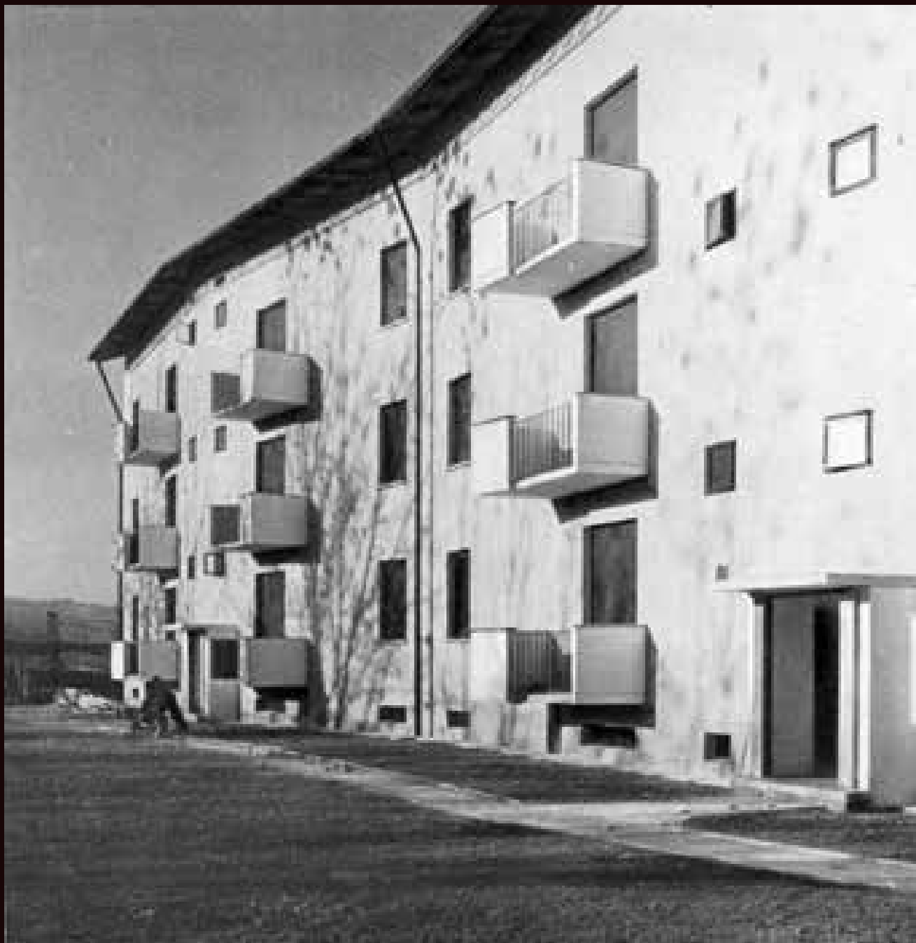
Facciata Casa Ina a tre piani, con alloggi di cinque vani per famiglie operaie (da Amodei, Gabetti, Raineri architetti, Casa lungo il Po , in «Domus», n. 283, giugno 1953, p. 12)
