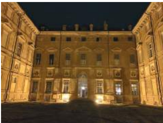
fig. 3 – Castello di Aglié. La corte interna di San Massimo, vista da sud verso nord.
