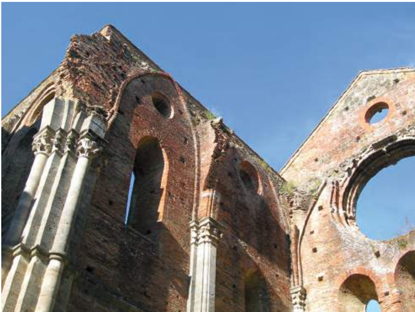
fig. 2 – Chiusdino (Siena): le rovine dell'abbazia di San Galgano, eccezionale intervento di conservazione allo stato di rudere realizzato da Gino Chierici negli anni Venti del secolo scorso.
