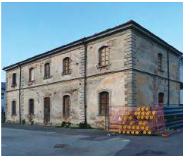
fig. 7 – La ex stazione ferroviaria di Barge prima dell'intervento di restauro del 2021-2022 (fotografia di G. Beltramo, 2018).
