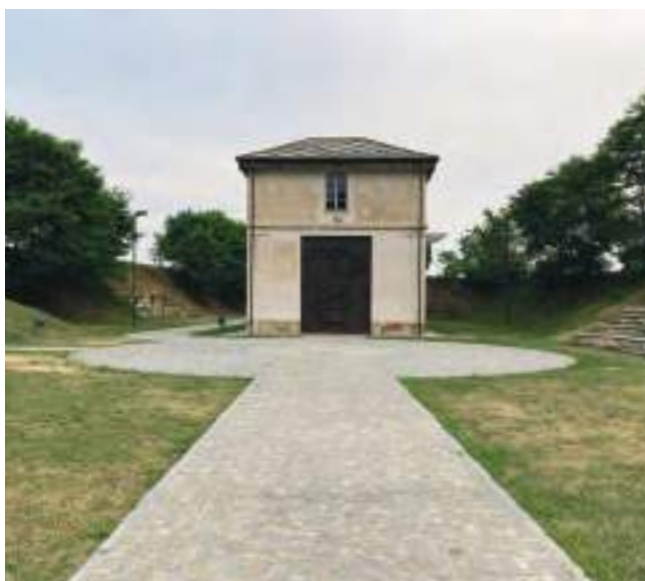
fig. 9 – L'ex officina ferroviaria di Barge, ora spazio espositivo per mostre temporanee, in seguito al restauro (fotografia di G. Beltramo, 2022).
