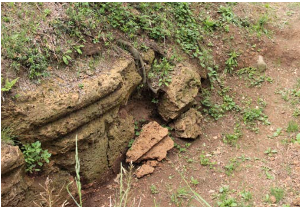
(Fig. 6.49) Le radici di un leccio hanno provocato il distacco di parte del tamburo di un tumulo
