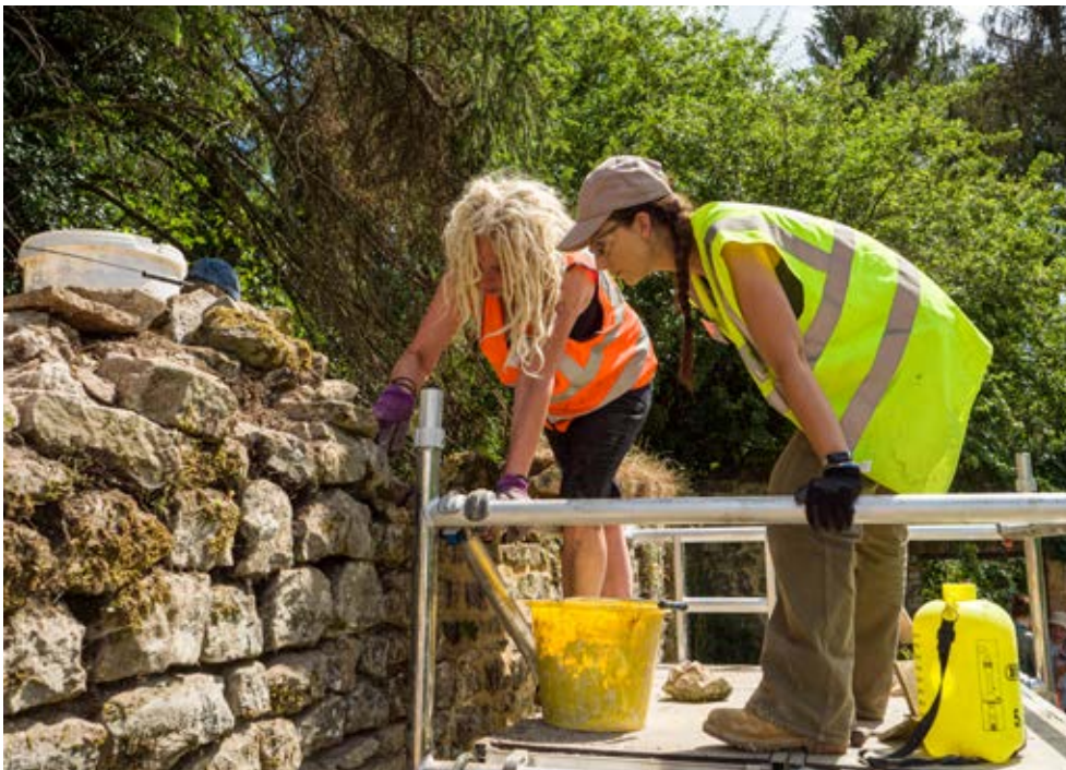
(Fig. 6.35, 6.36) Alcune delle attività svolte durante il periodo di lavori
