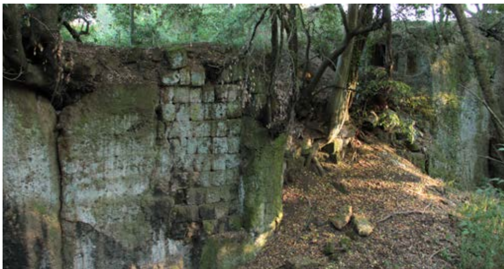
(Fig. 1.7-1.9) I resti delle fortificazioni etrusche di Caere, in parte scavate nel tufo e in parte costruite in opera quadrata
