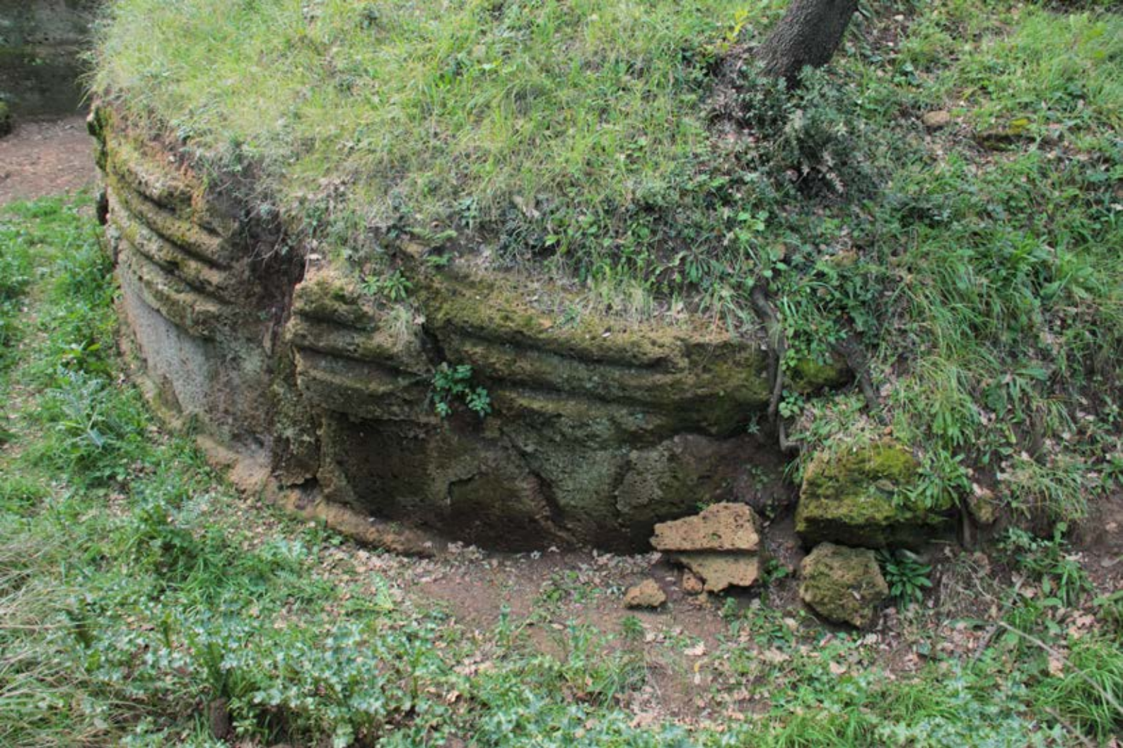
(Fig. 3.15,3.16) In questa pagina e nella successiva. Rispettivamente, un tumulo e una tomba a dado che presentano gravi lesioni dovute alle radici di alberi cresciuti al di sopra
