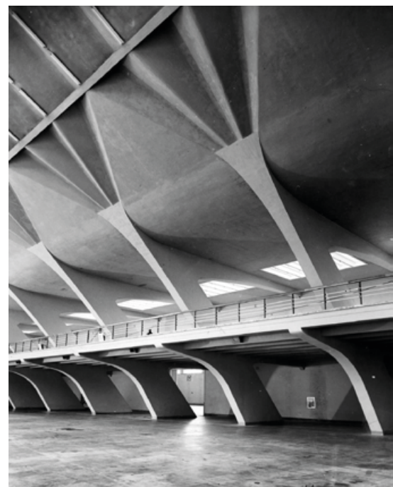
Salone B di Torino Esposizioni, attacco a terra dei pilastri. Courtesy Fondation PLN Project
