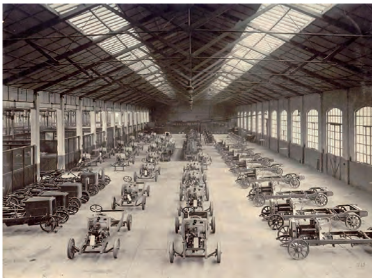
Fig. 1 Stabilimento Clément-Bayard Diatto. Padiglione industriale, Torino, 1905. Clément-Bayard Diatto, plant. Industrial pavilion, Torino, 1905. (© MAUTO Museo Nazionale dell'Automobile - Centro di Documentazione, Torino)
