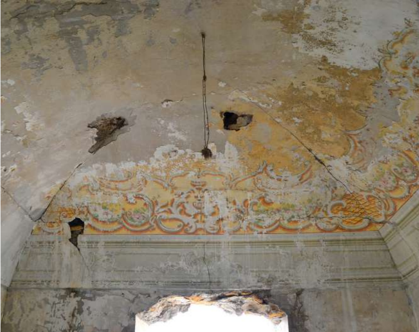
Una delle volte decorate che si conservano ai piani nobili degli edifici di Poggioreale / One of the decorated vaults preserved on the noble floors of the Poggioreale buildings
