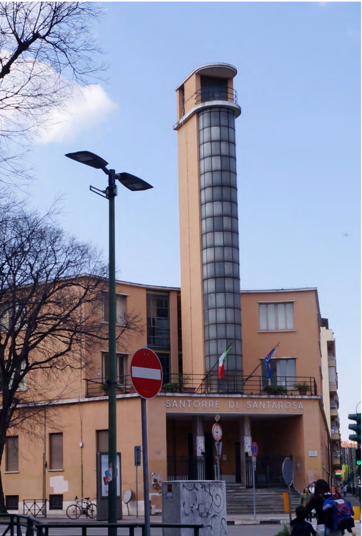
Le edificio della casa del fascio Amos Maramotti, dopo la guerra divenne la scuola Santorre di Santarosa - Foto di Luca Davico
