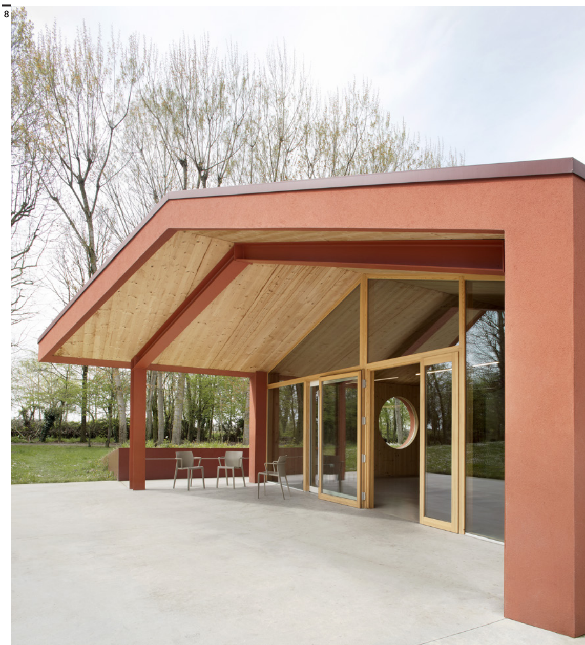
Fig. 6 Casa 4, Magnago, Milano, LCA architetti, 2016.
