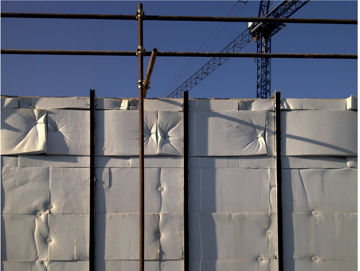
10 | Edificio in costruzione. Crediti fotografici: Andrea Levra Levron Building under construction. Photo credits: Andrea Levra Levron
