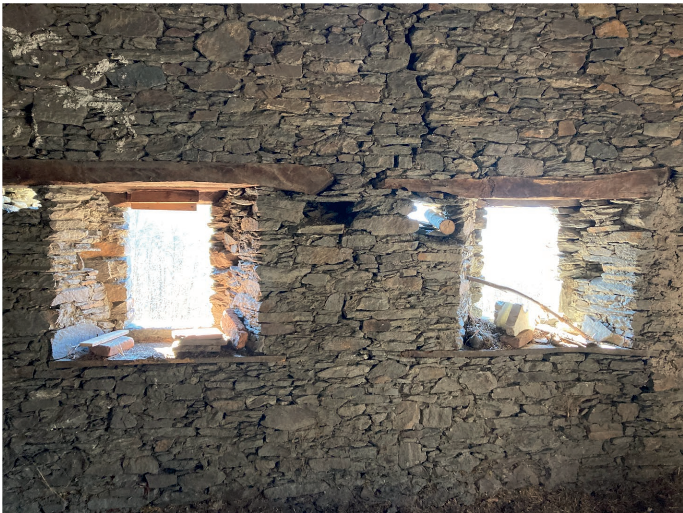
11 | Borgata storica in zona sismica, Villar Perosa (TO). Crediti fotografici: Andrea Veglia Historic hamlet in seismic zone, Villar Perosa (TO). Photo credits: Andrea Veglia
