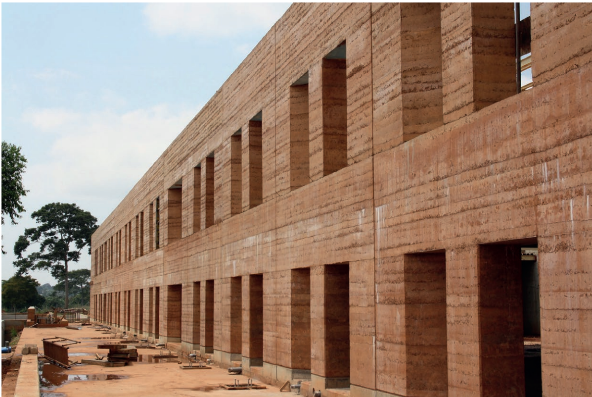
02, 03 | Ospedale di chirurgia pediatrica di Emergency, Uganda. Progetto: RPBW TAMassociati e Building Division di EMERGENCY; Progetto strutturale: Buro Milan; Particolare della costruzione del muro portante in terra cruda, tecnica costruttiva del "pisè" (rammed earth technique). Crediti fotografici: Maurizio Milan Emergency Children's Surgery Hospital, Uganda. Project: RPBW, TAMassociati e Building Division di EMERGENCY; Structural design: Buro Milan; Detail of the construction of the load-bearing earthen wall, a construction technique of "pisè" (rammed earth technique). Photo credits: Maurizio Milan
