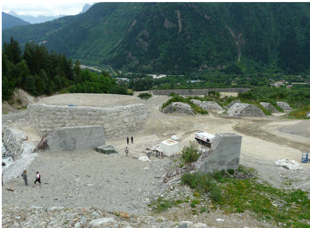
Figura 4.6 - Cumuli e cunei frenanti presso il bacino valanghivo a valle del ghiacciaio di Tacconaz - Monte Bianco (FR). Sullo sfondo la diga di contenimento. In primo piano due denti di rallentamento in cemento armato distrutti dall'evento valanghivo (Frigo, 2009).
