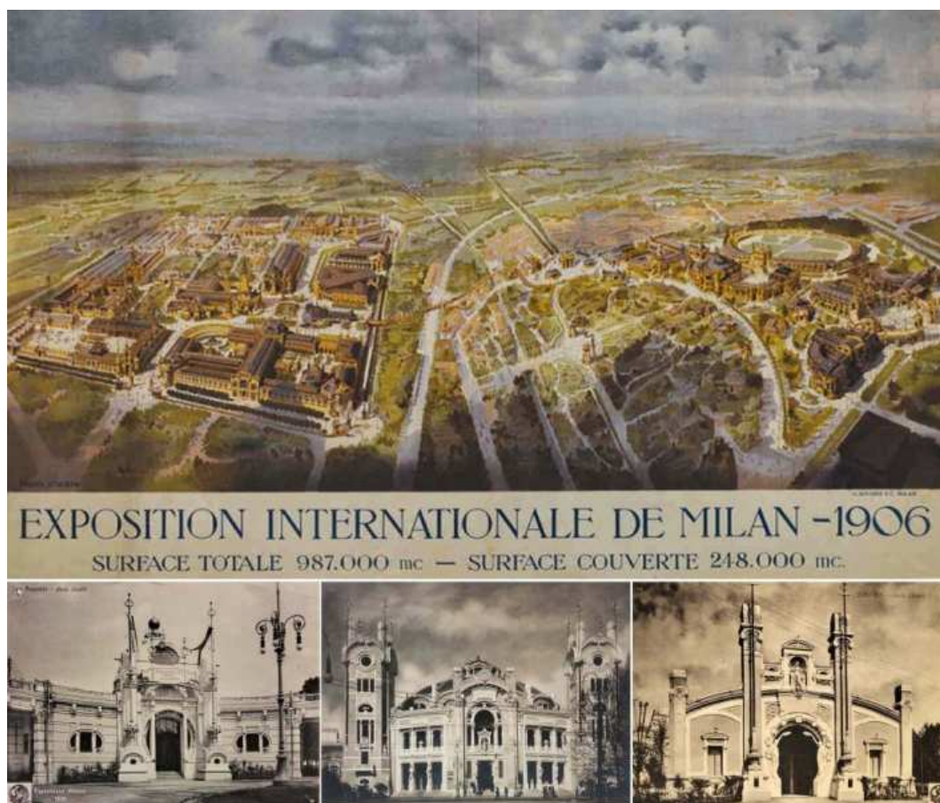
Fig. 3. Immagini storiche e cartoline d'epoca dell'Esposizione Internazionale 1906 di Milano. Dall'alto: vista a volo d'uccello delle due aree espositive dell'Expo 1906 a Milano < https://milanoneisecoli.blogspot.com/2015/01/la-ferrovia-sopraelevata-di-expo-1906.html > (ultimo accesso 20 ottobre 2023); cartoline d'epoca raffiguranti l'edificio dell'Acquario, il Salone dei Festeggiamenti e il Padiglione delle Belle Arti (Archivio Disegni del DICAr dell'UNIPV).
