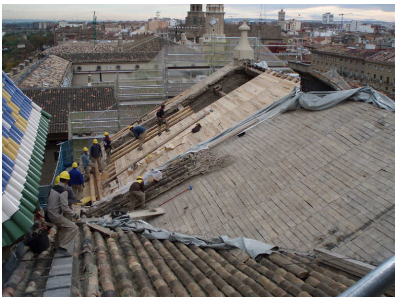
Fig. 1. Saragozza (Spagna) Basilica del Pilar, cantiere di rinnovo della copertura (foto I. Ruiz Bazán 2006).
