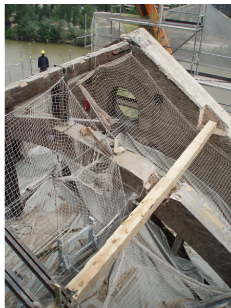
Fig. 2. Saragozza (Spagna) Basilica del Pilar, cantiere di rinnovo della copertura (foto I. Ruiz Bazán 2006).
