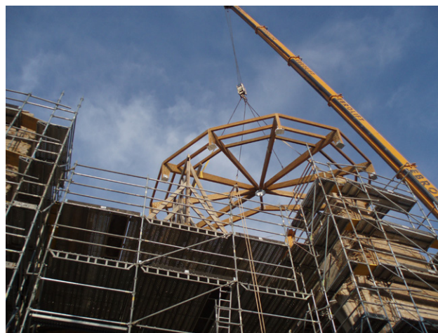
Fig. 4. Magallón (Spagna). Ex-chiesa di Santa Maria del la Huerta, consolidamento delle rovine e trasformazione in auditorio, montaggio della copertura in legno lamellare (foto I. Ruiz Bazán 2007).
