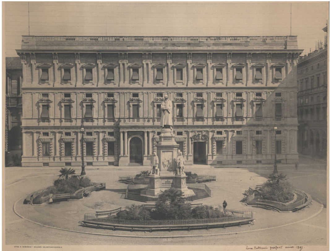
4. Milano. Palazzo Marino, facciata su piazza della Scala, 1890-1891. Fotografia di Arturo Demarchi. Milano, Civico Archivio Fotografico, Raccolta Luca Beltrami, RLB 2954/A.
