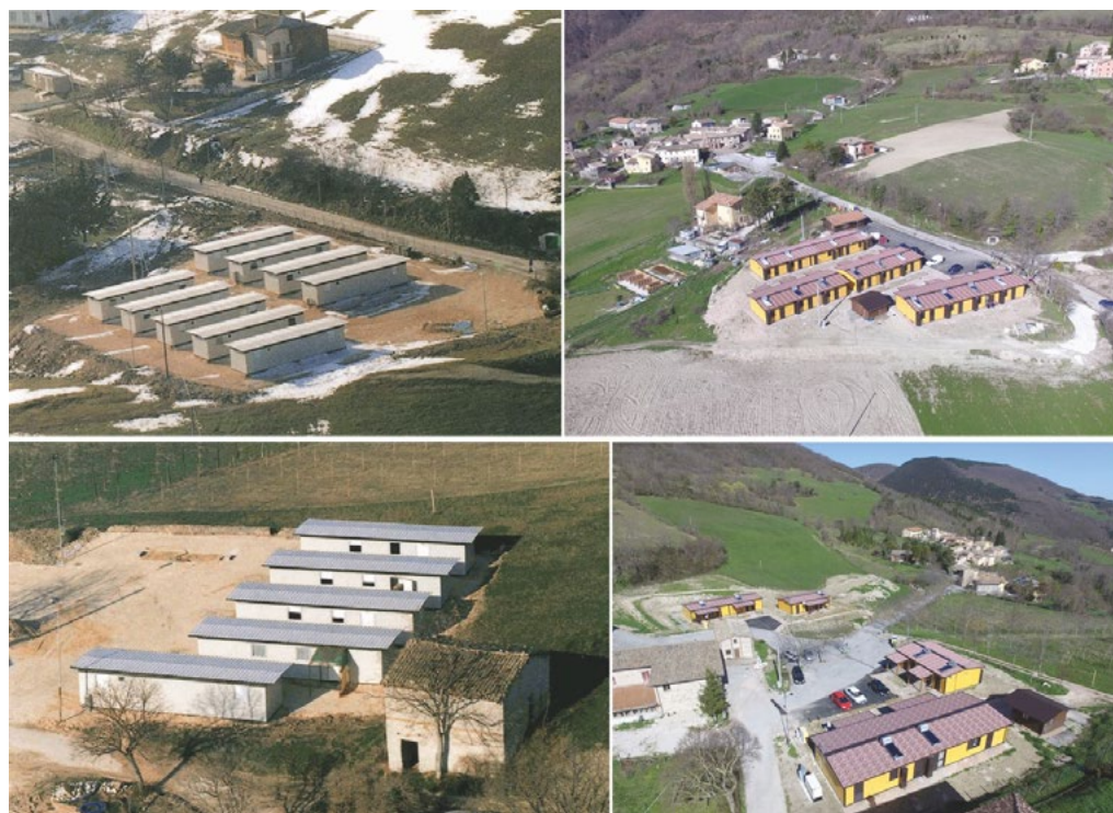
4: Le medesime aree a Costafiore (in alto) e Massapofoglio (in basso), frazioni di Muccia (MC), allestite per l'emergenza abitativa nel post-sisma del 1997 come campi container (a sinistra) e riutilizzate come aree per le Soluzioni Abitative d'Emergenza post eventi 2016/2017 (a destra). Le immagini a sinistra sono tratte dalla pubblicazione del Presidenza del Consiglio dei Ministri - Dipartimento della Protezione Civile. (1998). Insediamenti di emergenza in Umbria e Marche: crisi sismica 1997-1998, mentre le immagini a destra sono tratte dalla mappa interattiva nel sito della Regione Marche. https://www.regione.marche.it/Regione-Utile/Terremoto-Marche/SAE-soluzioni-abitative-in-emergenza .
