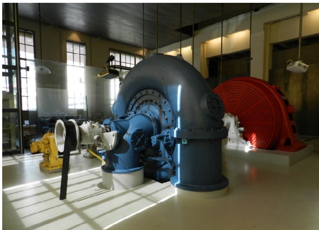
2: Museo dell'Energia idroelettrica, Cedegolo (Brescia). (foto Manuela Mattone 2017).
