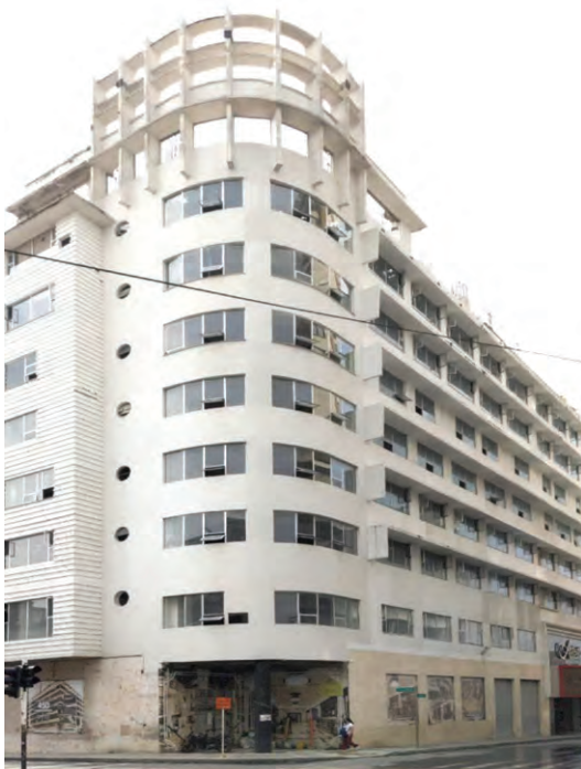
L’hotel Artisti di Cali, costruito nel 1951 e oggi trasformato in centro commerciale (fonte https://www.domusweb.it/it/architettura/2024/06/17/chi-sta-distruggendo-larchitettura-deco-nella-citt-pi-pericolosa-della-colombia.html - u.c. 21/06/2024).
