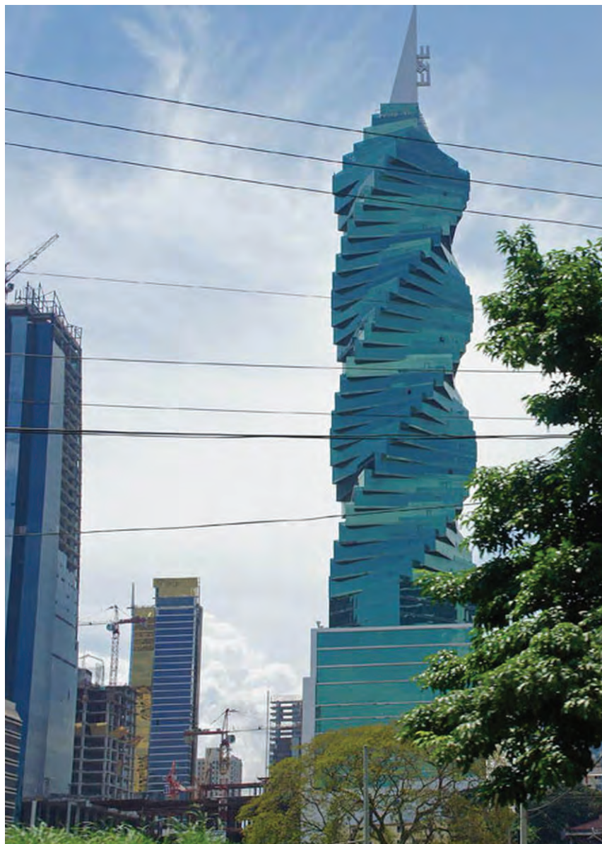
La Revolution Tower (el Tornillo) di Panama, progettata e realizzata dagli architetti Pinzon Lozano & Asociados (2008/11)
