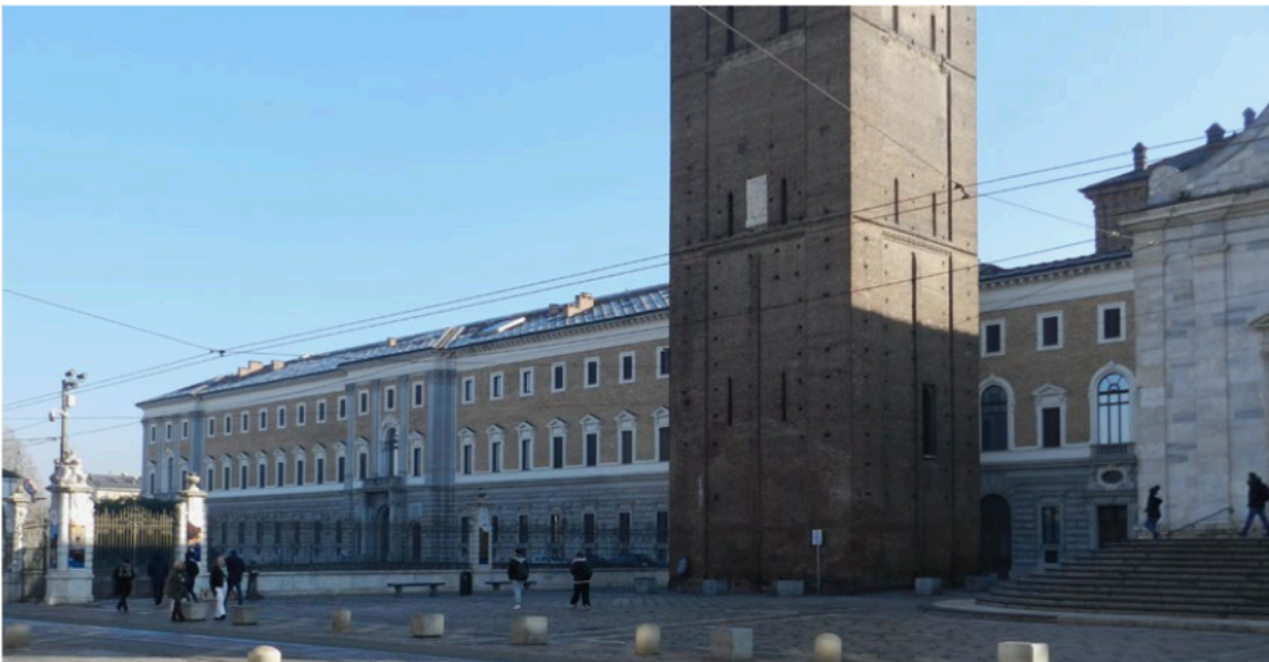
Figura 4. Torino, Palazzo Reale – Manica Nuova, prospetto esterno (foto M. Mattone 2024).
