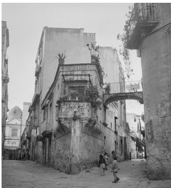
Figura 1. Napoli, vico Cimitile. Esempio di un ambiente urbano (Archivio fotografico Roberto Pane, NAP.N.112_0006).
