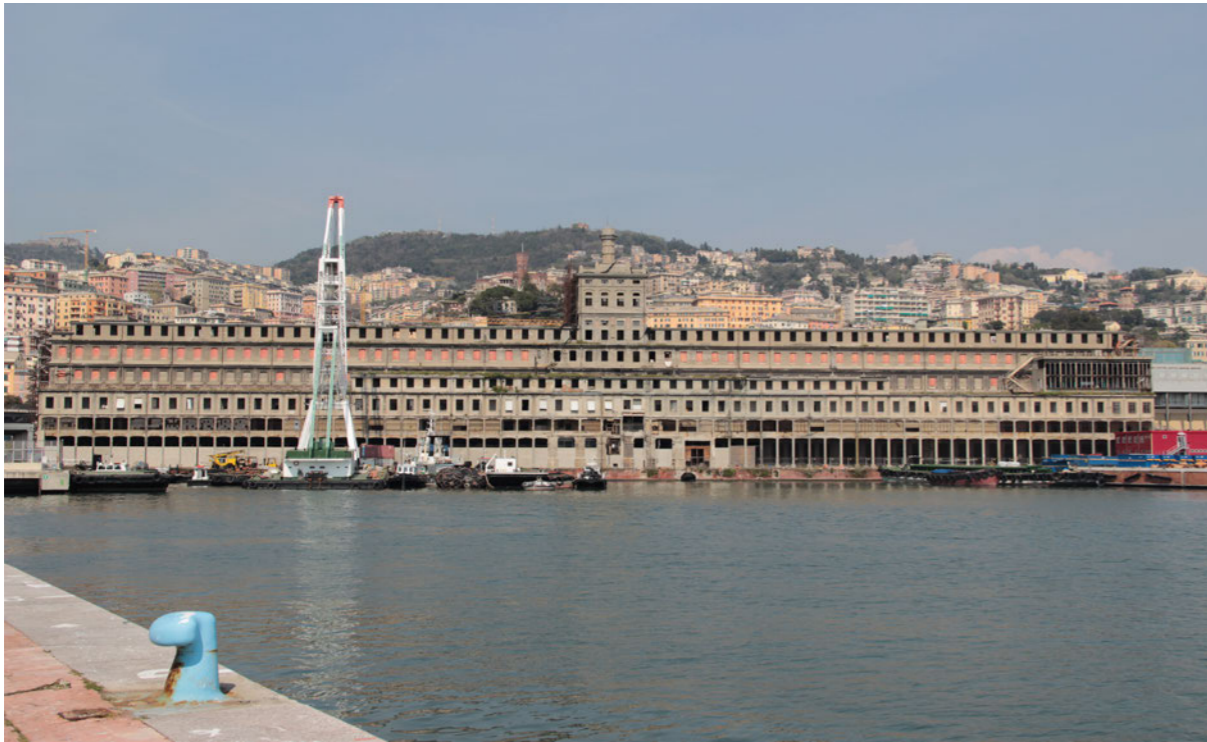
Fig. 6 - I silos Hennebique nel porto di Genova (fonte immagine: https://smart.comune.genova.it/articoli/entro-le-state-al-la-rinascita-dellhennebique-bucci-tassello-importante-del-centro-storico ).
