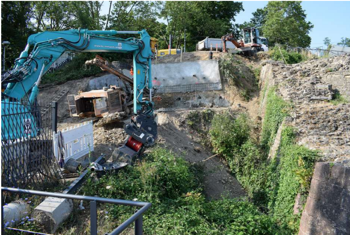
Fig. 6 - Le attività di cantiere per la costruzione del percorso di collegamento con la cittadella. Foto dell'autore, 2023.
