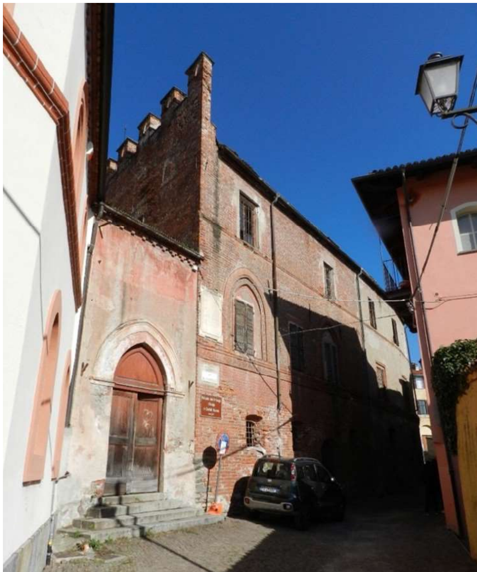
Figura 5. Fachada del palacio de via al Castello, antes de la intervención de reintegración de los ladrillos (otoño 2016).
