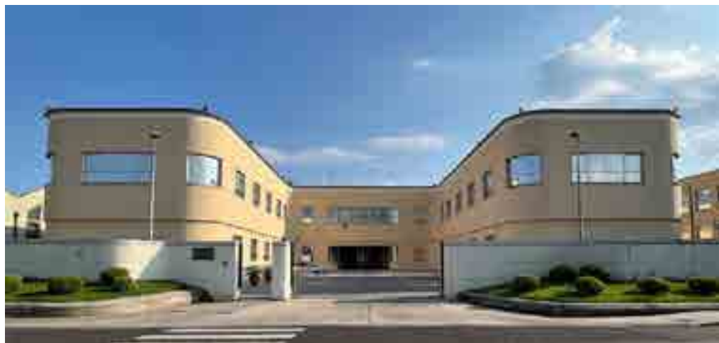
4: Pontedera, Palazzina direzionale (foto dell'autore).
