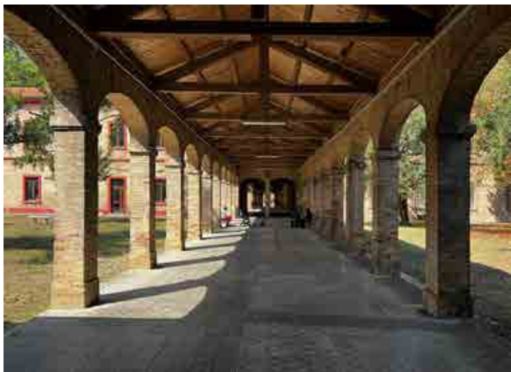
4: Ex Manicomio provinciale di Ancona, 2022 [foto dell'a.]
