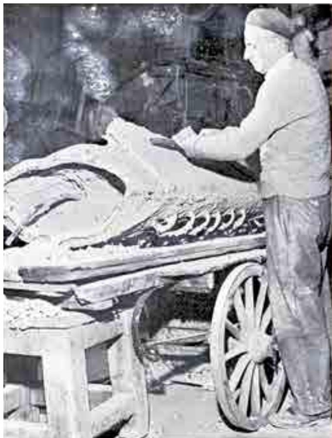
4: Attività di fonderia lavorazione e sistemazione delle terre di fusione (1959).
