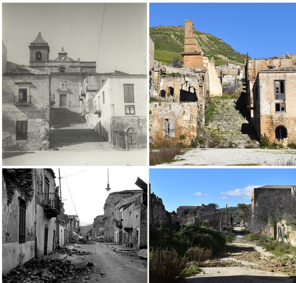
4: Poggioreale dopo il terremoto del 1968 e oggi. In alto: la Chiesa Madre da Piazza Elimo [a sx: anonimo, a dx: foto degli autori]. In basso: Corso Umberto I in direzione dell'ingresso alla città da ovest [a sx: anonimo, a dx: foto degli autori].
