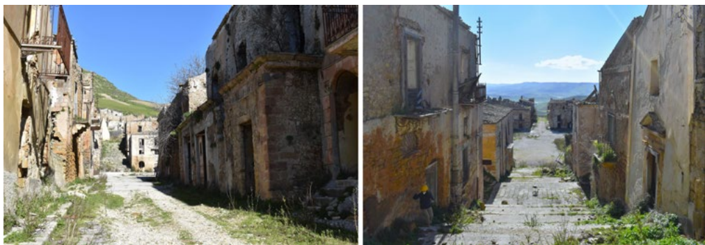
2: Poggioreale antica oggi. A sinistra: via regina Margherita in direzione di Piazza Elimo; a destra: Piazza Elimo dalla scalinata della Matrice [foto degli autori].
