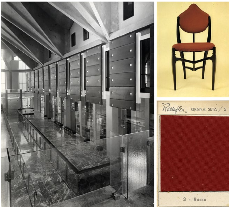
Fig. 7 - Roberto Gabetti, Aimaro Isola, Giorgio Raineri, Borsa Valori, Torino, 1952-56. Vista del Salone delle Contrattazioni con pannelli fonoassorbenti, mancorrenti e arredi interamente rivestiti in Resinflex; sedia per gli uffici; campione originale di Resinflex rosso grana "Seta" (Foto Riccardo Moncalvo, Archivio Riccardo Moncalvo; Archivio Gabetti e Isola; Archivio Resinflex).
