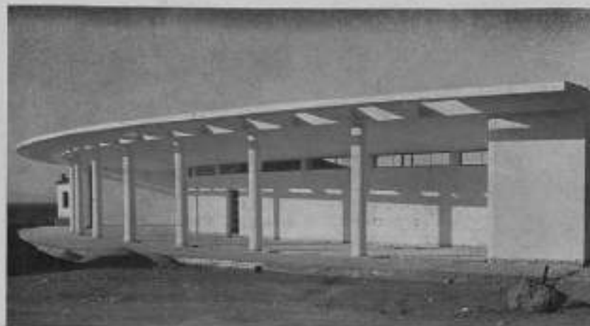
FAÇADE SUD, CAISSONS DE L'AUTENT ENLEVÉS
