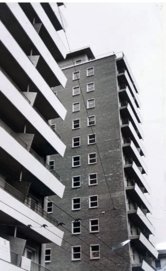
Fig.2 - I due edifici in un'immagine di fine cantiere, prima metà degli anni cinquanta (UNITS, ASCR, fondo Costa)
