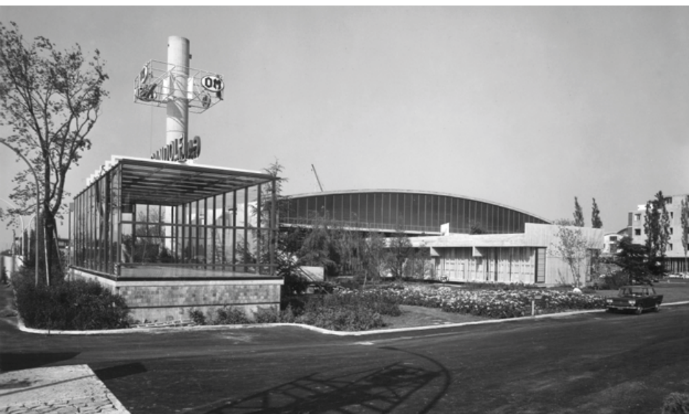
Fig.1 - Fronte del complesso sulla via Emilia. In primo piano gli uffici e i locali di accoglienza (Archivio Architetto Glauco Gresleri)
