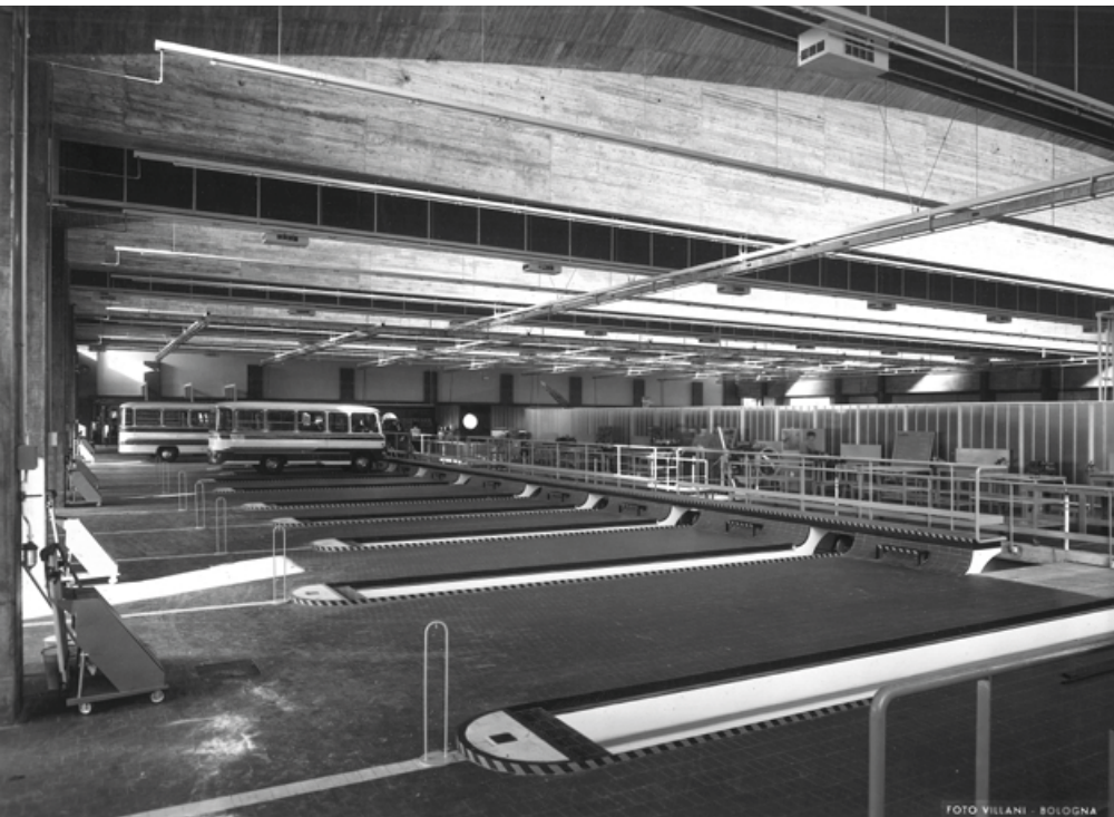
Fig.5 - Fosse di lavorazione. In testa alle fosse la passerella superiore ed il corridoio inferiore di collegamento trasversale. Più oltre ancora lo spazio del macchinario e la vetrata in u-glass che chiude il magazzino ricambi (Archivio Architetto Glauco Gresleri)
