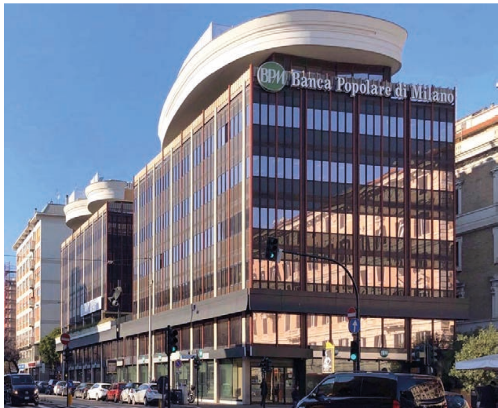
Fig.3 - Un'immagine dell'edificio di piazzale Flaminio precedente agli interventi in corso
