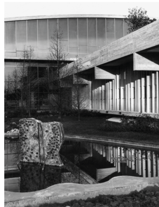
Fig.2 - La struttura della palazzina uffici è formata da un solaio con alti bordi di risvolto per il contenimento del giardino pensile, appoggiato su telai in cemento armato costituiti da coppie di pilastri circolari e travi piatte. Il tamponamento è costituito da vetrata semifissa con montanti prefabbricati in cemento posti a distanze modulari. Scultura in acqua di Giuliano Gresleri (Archivio Architetto Glauco Gresleri)
