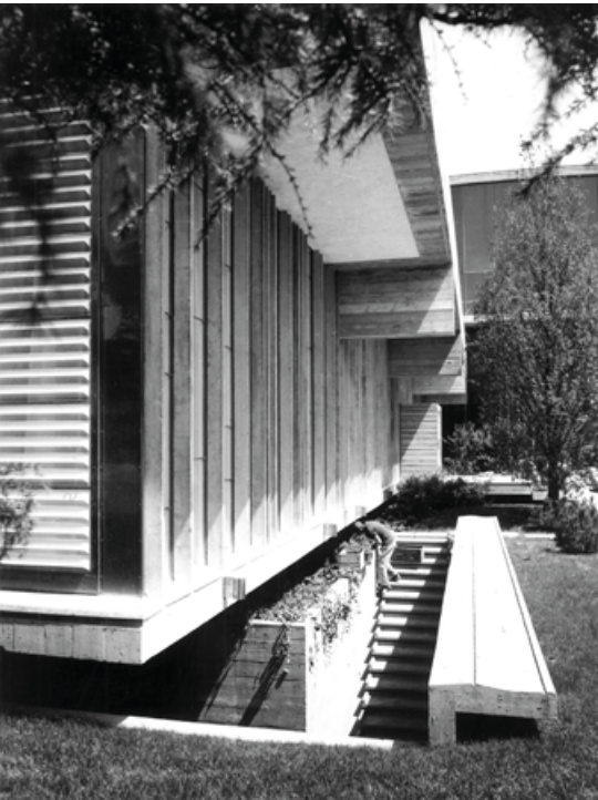
Fig.3 - Corpo degli uffici. Vetrata continua modulare in c.a. e vetro, la copertura a sbalzo contenente il giardino pensile, la vetrata a sud in perspex con funzione frangisole, e la scala al piano seminterrato del magazzino (Archivio Architetto Glauco Gresleri)
