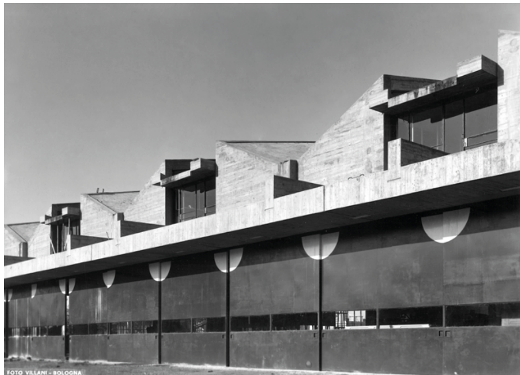
Fig.4 - Fianco est del corpo centrale del complesso. Le solette piane appese tra le travi contigue di copertura sporgono in aggetto con i 'boccacci' per lo scarico dell'acqua a pelo libero (Archivio Architetto Glauco Gresleri)
