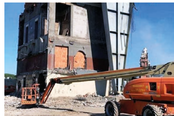
Fig.8-10 - Lo smontaggio della trave a sbalzo e la progressiva demolizione dell'autogrill di Montepulciano, 2021 (fotografia dell'autrice)
