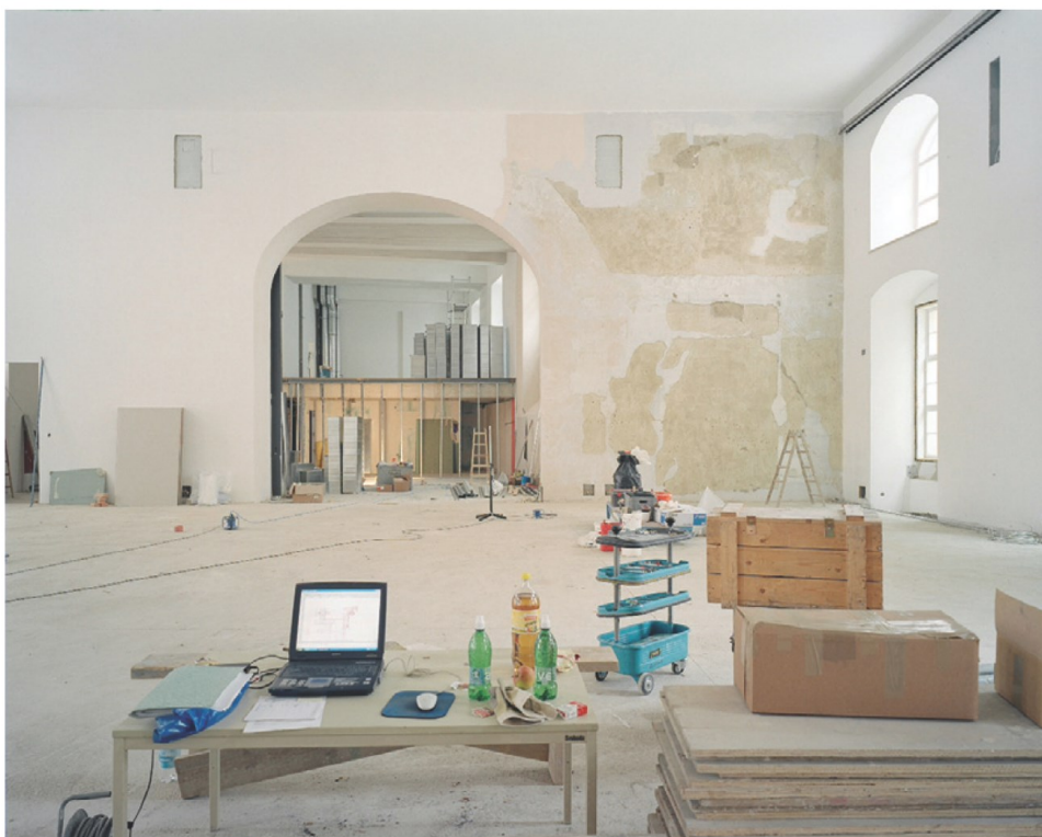
Ilustracja 3. „Niespodzianki” fresku. Nowe malowidło ścienne zostało odkryte podczas prac remontowych (na lewo od okna), co uniemożliwiło dokończenie prac mających na celu renowację ściany w głębi fotografii. (Zdjęcie autorki)
