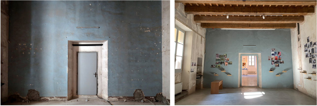
Fig. 1. 'Sala azzurra': stato di fatto prima e dopo l'intervento finanziato con il bando Culturability (foto CasermArcheologica e D. Dabbene 2021).
